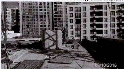
Sector corte de material en cubierta entre torres A y B.
