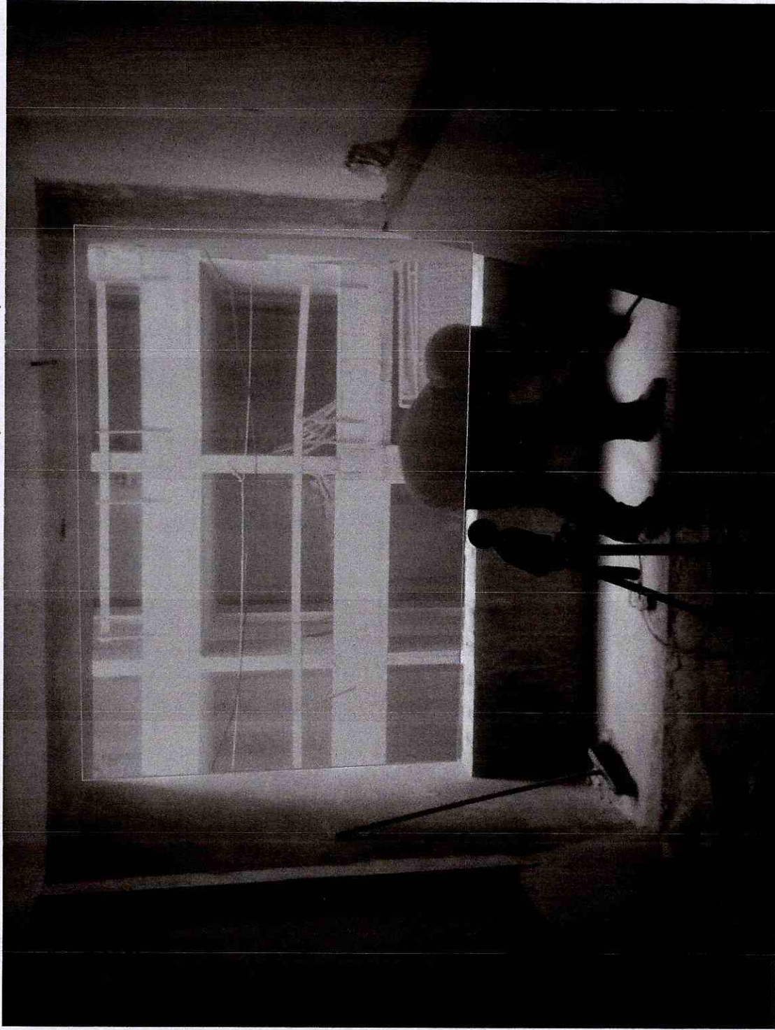
Figura 1. Ejemplo cierre de vanos en los que se realicen trabajos ruidosos con placas de madera OSB
