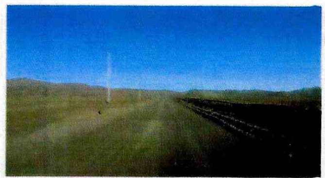
Figura N° 11: Tubería camino a Piscina de Agua de Mar.
