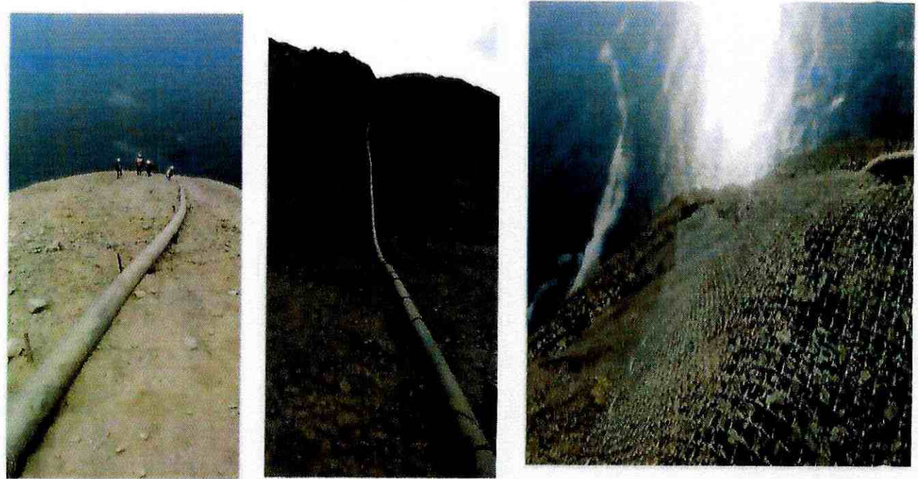
Figura N°9: Tubería y Fortificación de Taludes.
