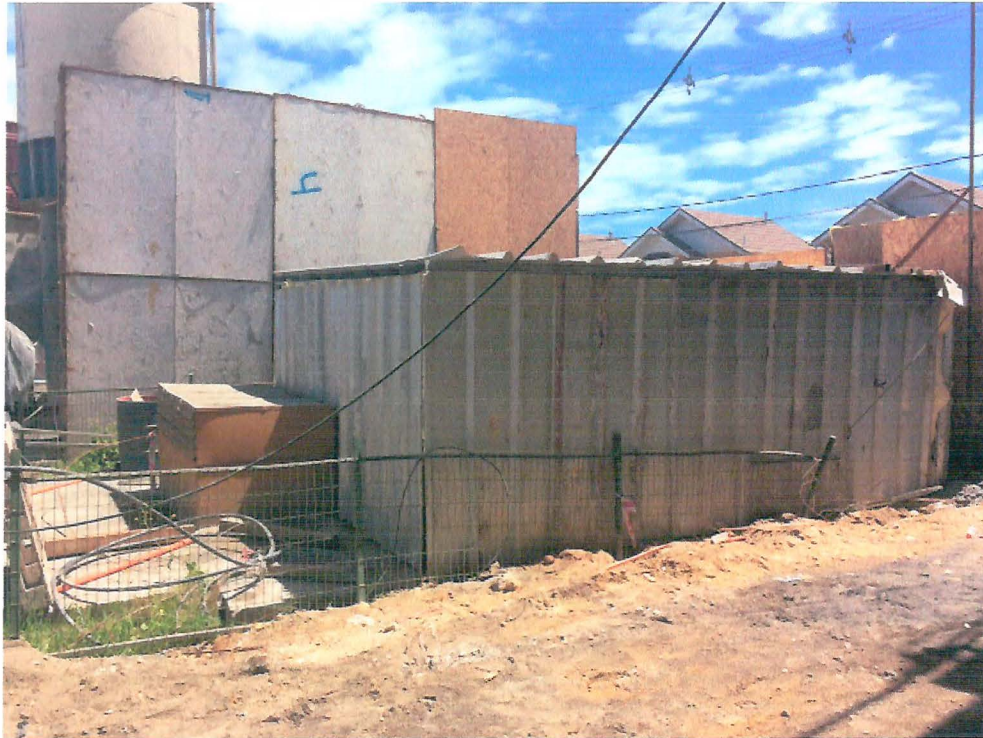
Fotografía 4: Semi-encierro acústico para faenas móviles o semi-fijas.
