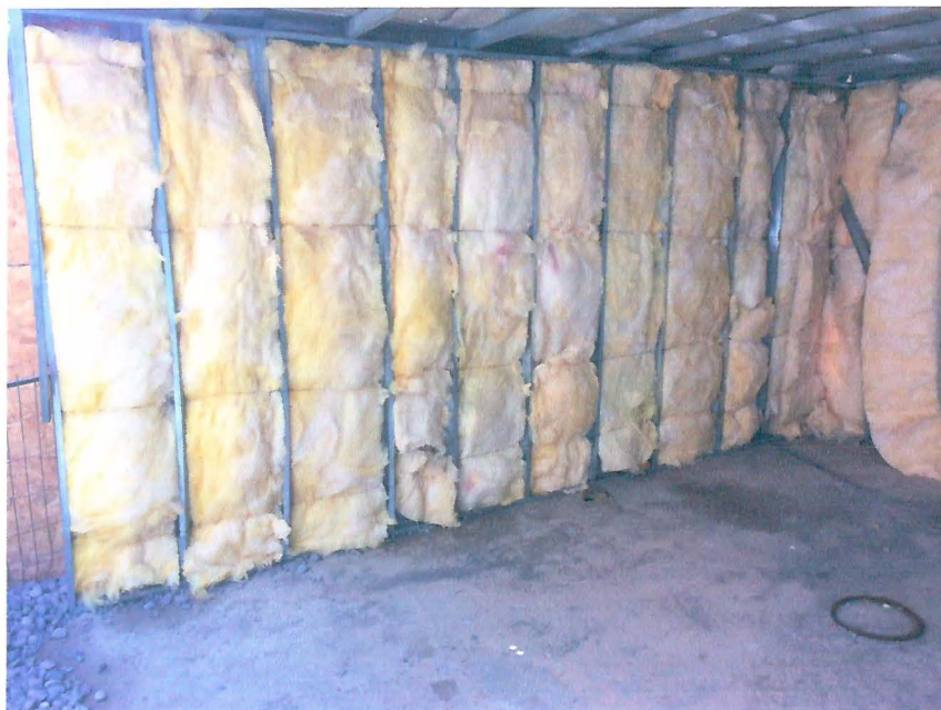
Fotografía 3: Semi-encierro acústico para faenas móviles o semi-fijas.
