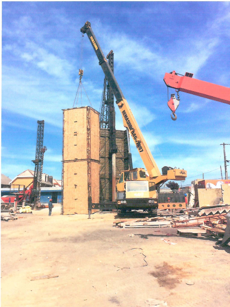
Fotografía 9: Encierros acústicos fijo y móvil de martinete Delmag D-12 en operación en pruebas de hinca.
