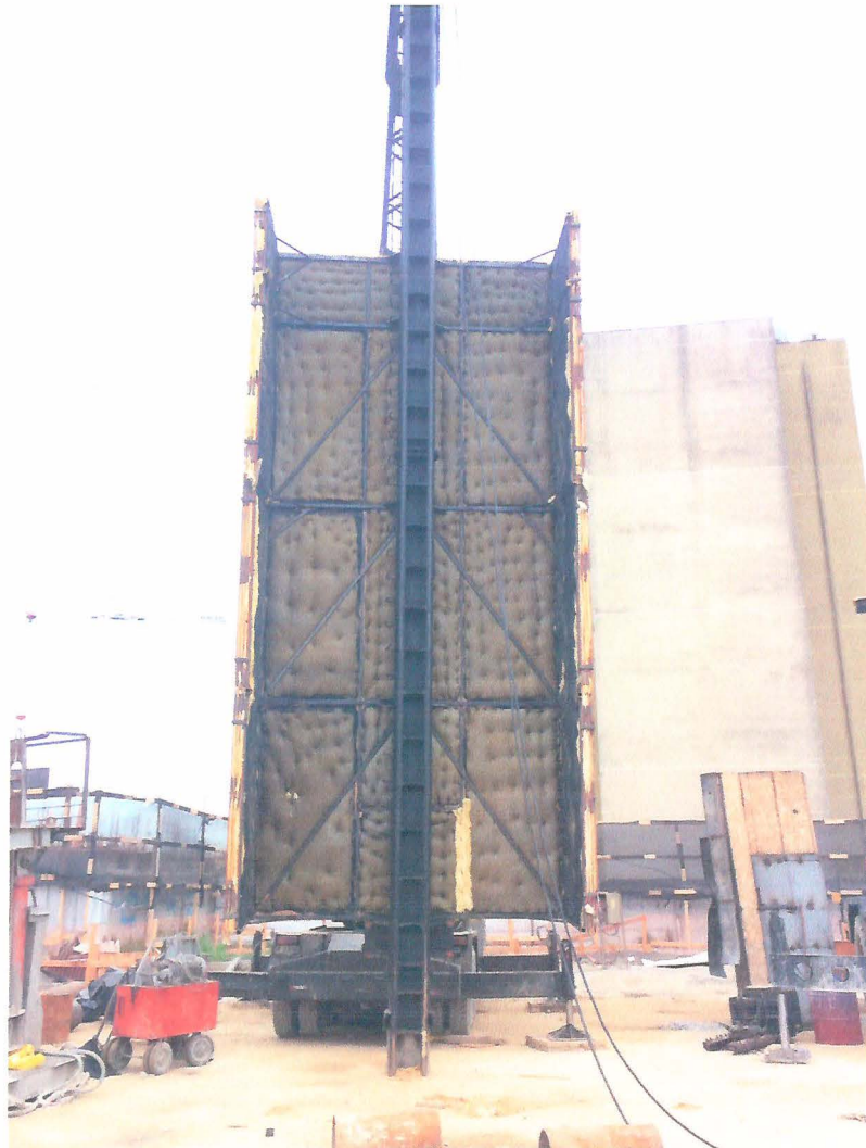
Fotografía 5: Encierro acústico tipo C fijo a torre guía de martinete Delmag-D12.
