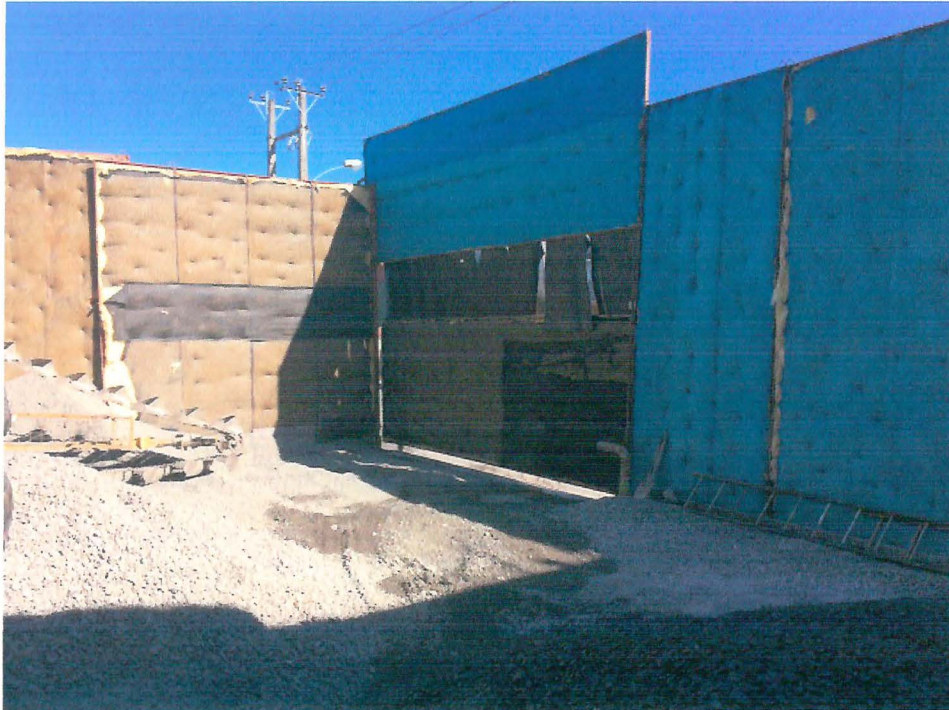
Fotografía 2: Encierros acústicos instalados planta de hormigón.
