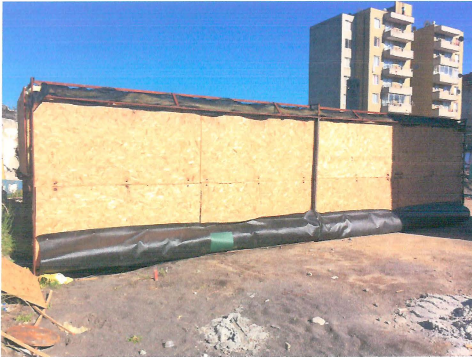
Fotografía 7: Encierro acústico móvil martinete Delmag D-12, h=9.60 m.
