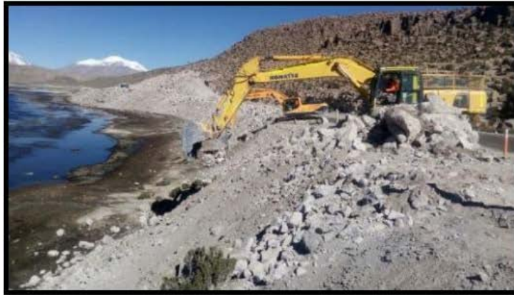
Trabajos de retiro de roca.
