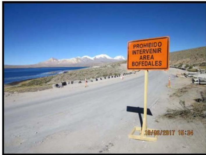
Señalética preventiva, km 178,480 (Muro TEM 7).
