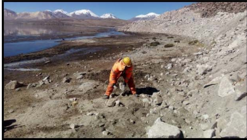
Retiro manual de roca.
