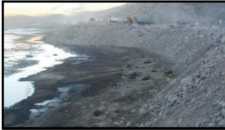
Trabajos de retiro de roca.
