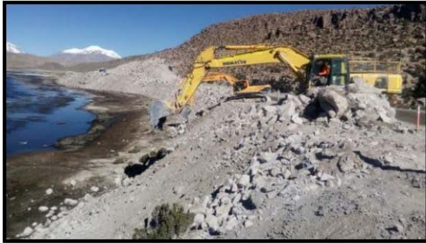
Trabajos de retiro de roca.
