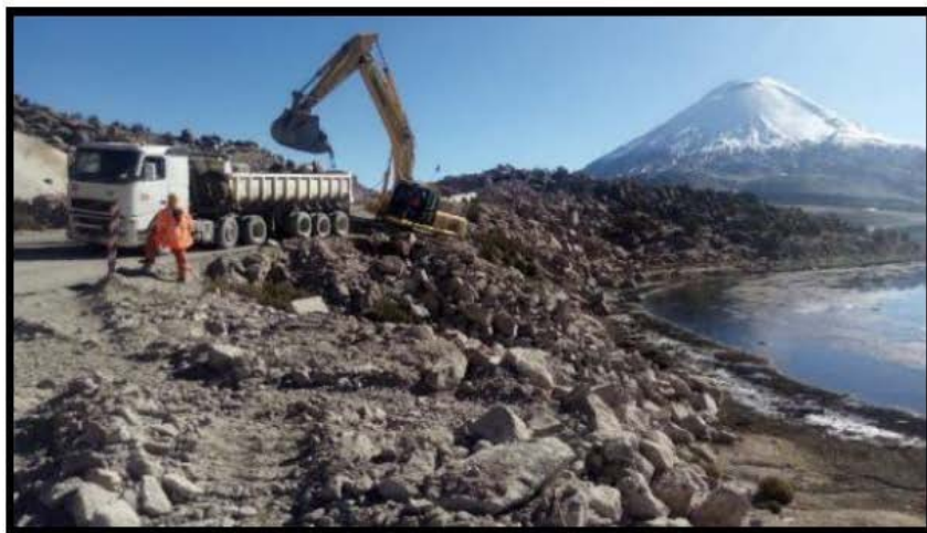
Trabajos de retiro de roca.
