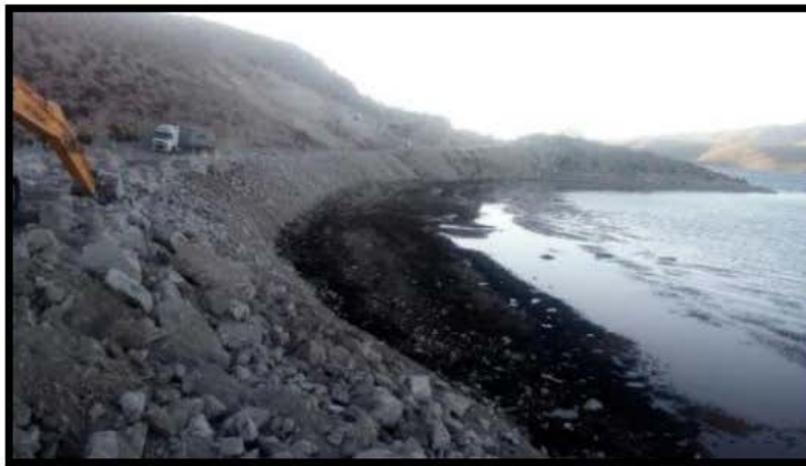
Trabajos de retiro de roca.
