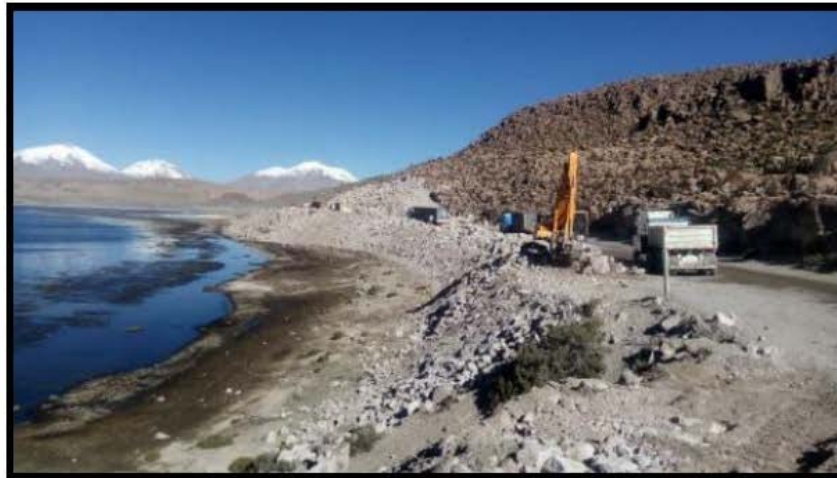
Trabajos de retiro de roca.
