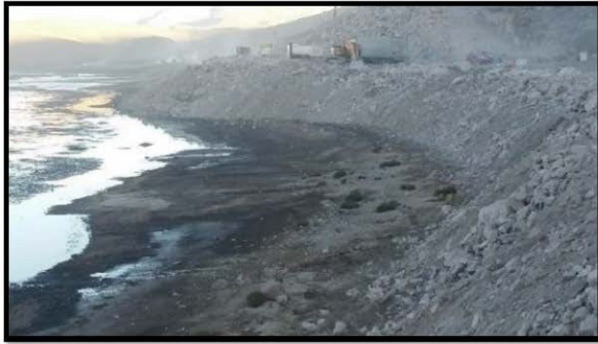
Trabajos de retiro de roca.
