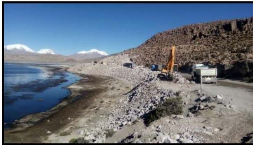
Trabajos de retiro de roca.
