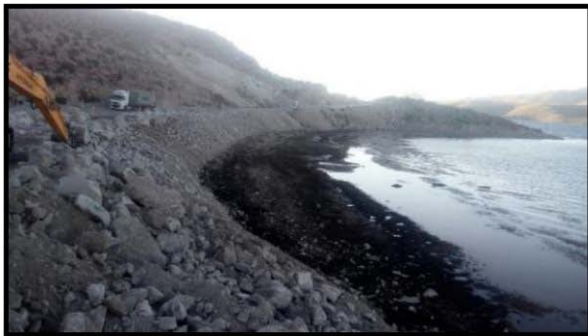
Trabajos de retiro de roca.
