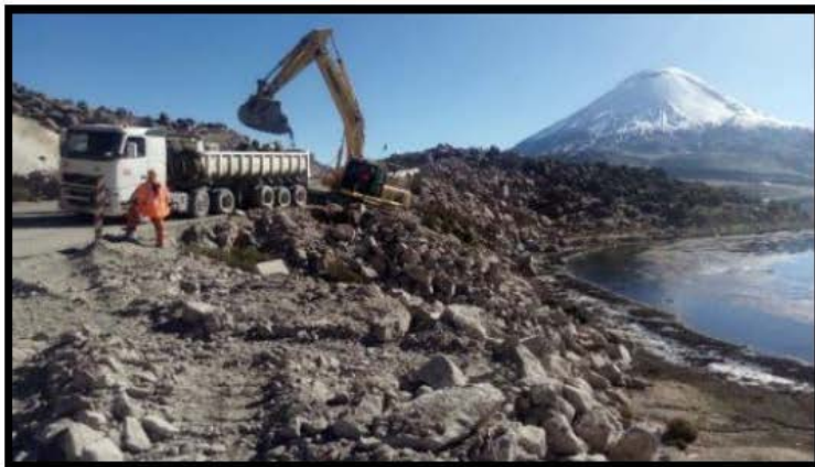
Trabajos de retiro de roca.
