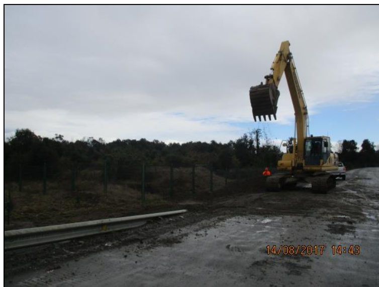
Imagen 2.12. Cierre de espacios de mayor tamaño con la ayuda de excavadora.
