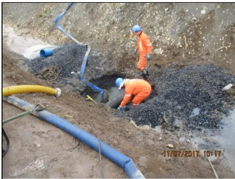
Imagen 2.2. Retiro de material, hasta llegar a la tubería preparando el terreno para la instalación de la guillotina. (Vista 2)
