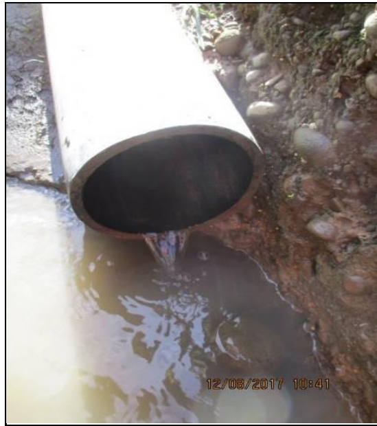
Imagen 2.5. Estado previo a sellado de tubería de aguas lluvias.
