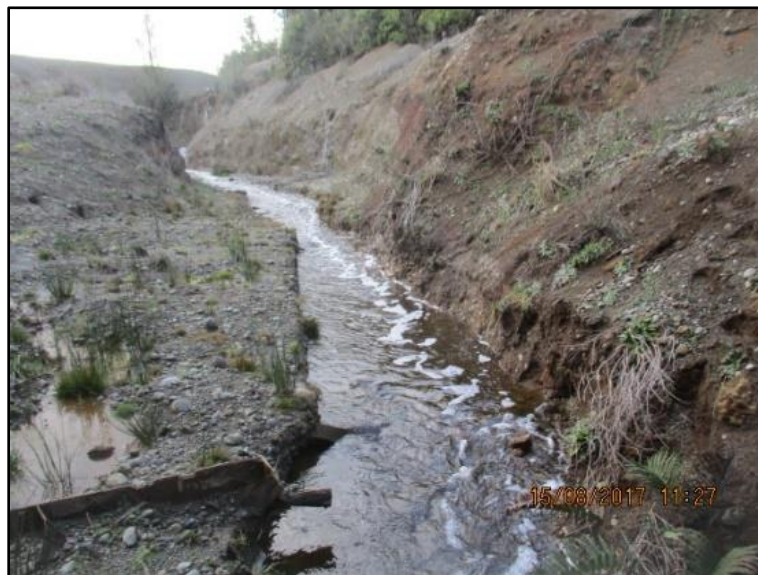
Imagen 2.14. Punto 2, registro limpieza estero sin nombre.
