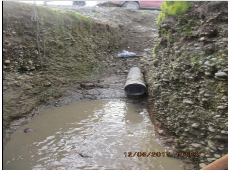
Imagen 2.9. Sellado hermético de la tubería, dando cumplimiento a la medida solicitada.
