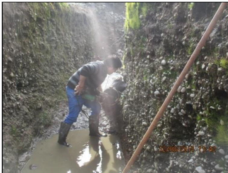
Imagen 2.8. Instalación tapón de HDPE y sellado con cordón extrusor de soldadura de HDPE de 1.5 mm. (Vista 3)
