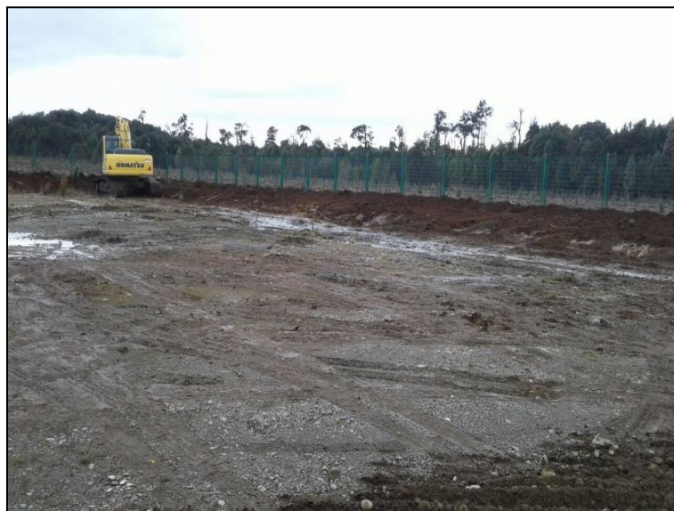
Imagen 2.11. Cierre de espacios de cerco, apoyado con la excavadora.
