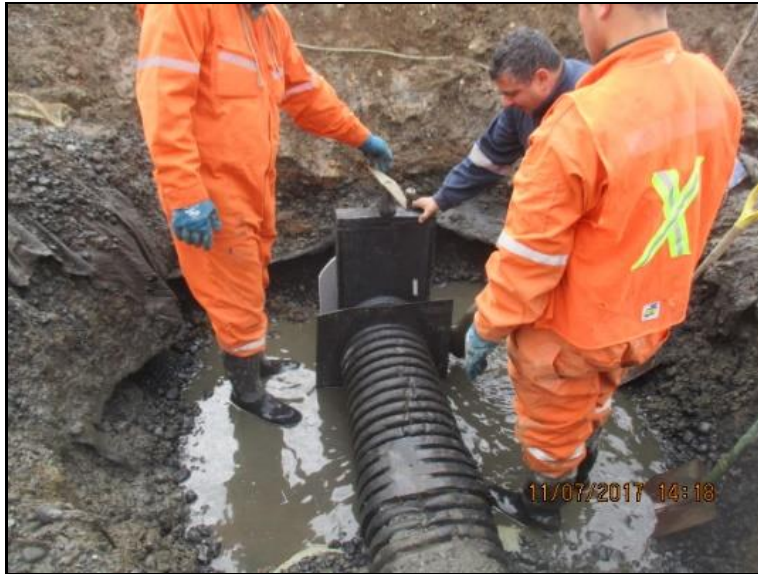
Imagen 2.3. Instalación y sellado de la guillotina a la tubería existente de conducción de lixiviados. (Vista 3)
