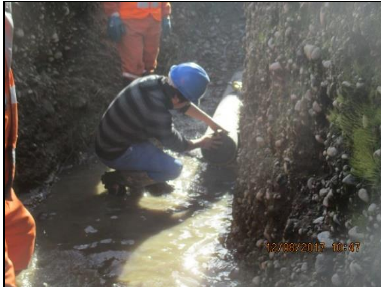
Imagen 2.7. Instalación tapón de HDPE y sellado con cordón extrusor de soldadura de HDPE de 1.5 mm. (Vista 2)
