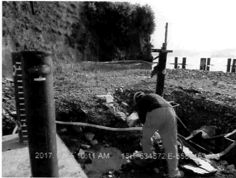
Imagen 5 Accionar de motobomba para la extracción de agua.
