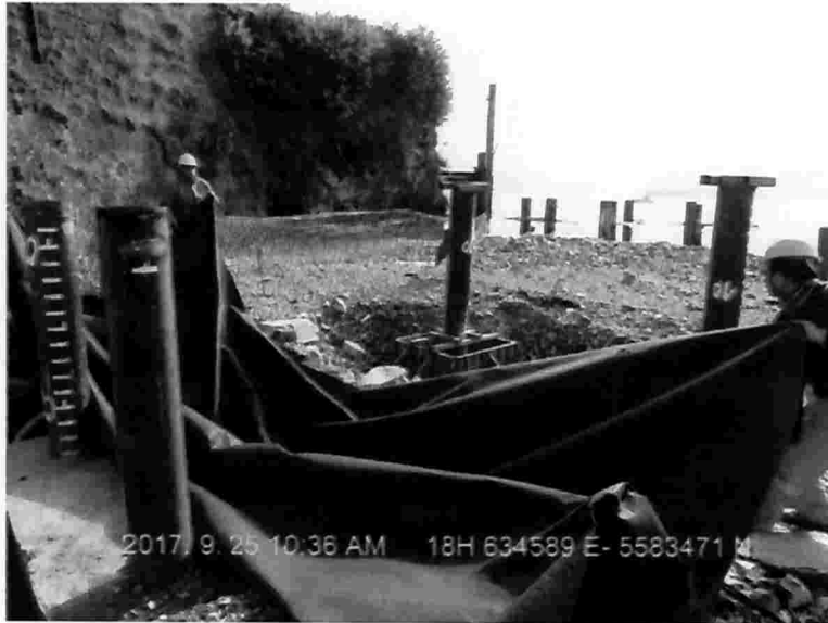
Imagen 8 Instalación de geotextil 1.
