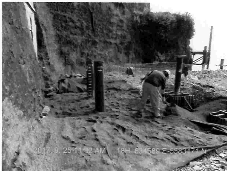
Imagen 13 Implementación de arena en excavación de Pilotes N°13 y N°16.
