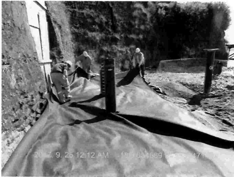
Imagen 15 Instalación de geotextil 2.
