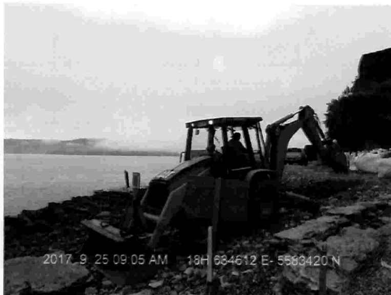
Imagen 1 Despeje de camino de acceso
