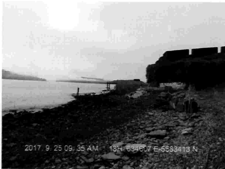
Imagen 3 Camino de acceso de maquinaria despejado.
