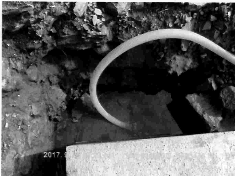
Imagen 6 Detalle de accionar de motobomba en excavación.
