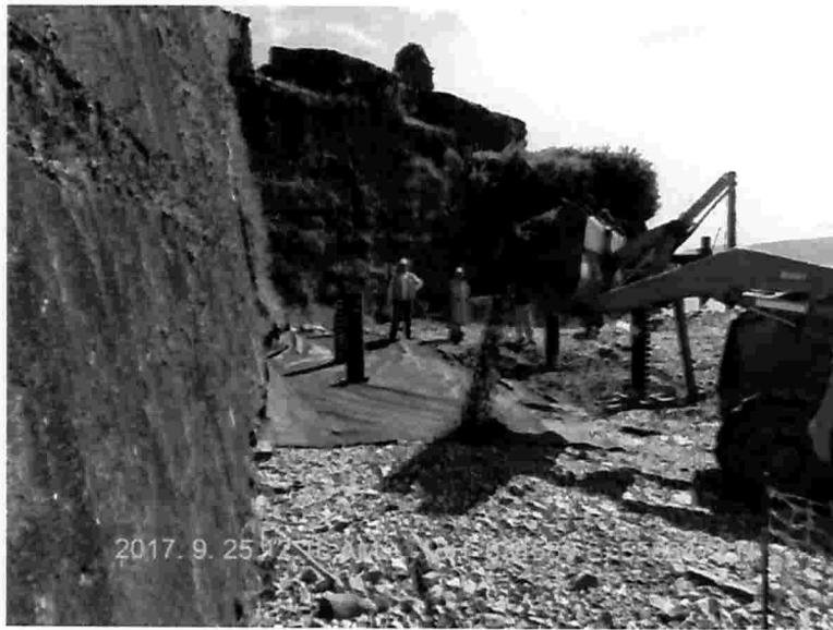
Imagen 16 Disposición de segunda capa de arena.
