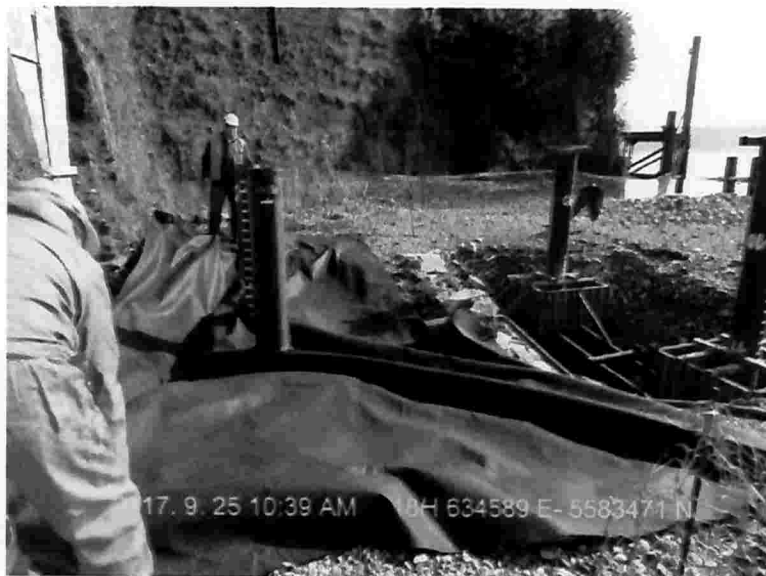
Imagen 9 Instalación de geotextil 1, con adecuación a pilotes.
