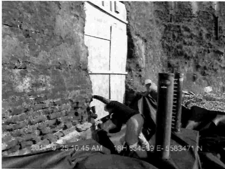
Imagen 10 Instalación de geotextil 1, en entrada de túnel.
