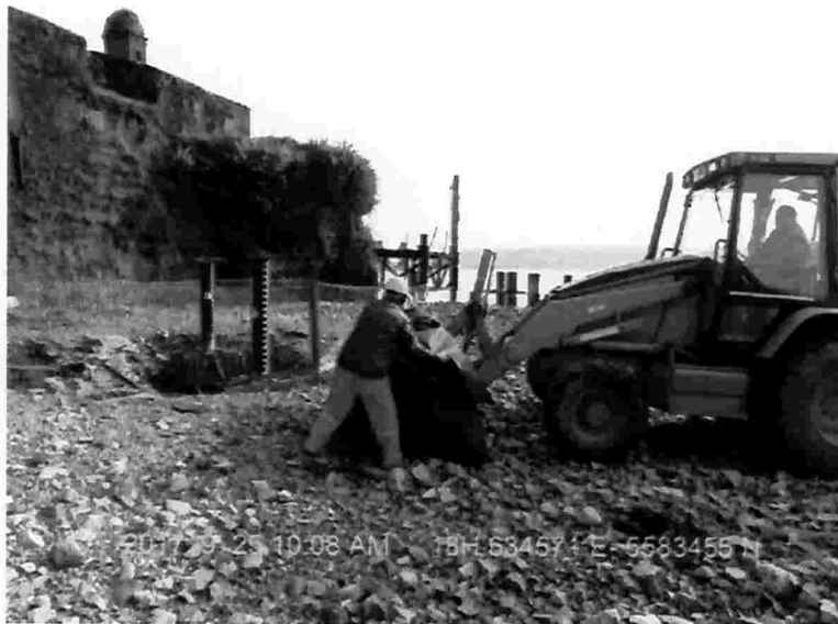
Imagen 7 Traslado de geotextil.
