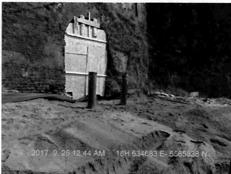
Imagen 19 Distribución manual y final de la capa de arena 2.
