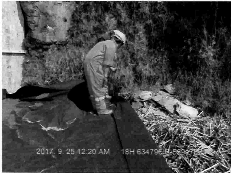
Imagen 18 Anclaje de geotextiles.
