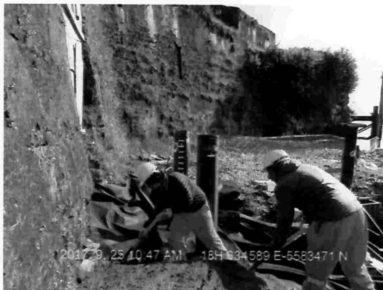
Imagen 11 Distribución de la primera capa de arena sobre el geotextil 1.
