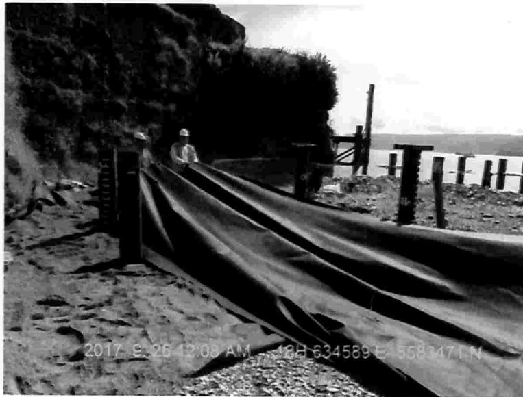
Imagen 14 Despliegue de geotextil 2.
