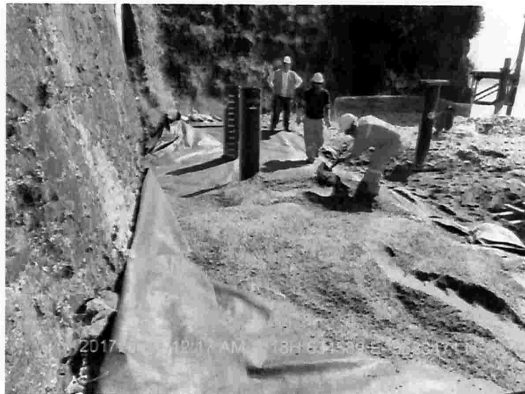
Imagen 17 Distribución manual e inicial de la capa de arena 2.
