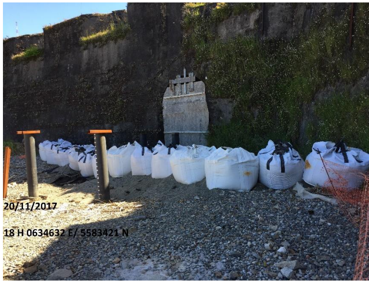
Imagen 38. Vista N hacia Medida Provisional de seguridad y control.
