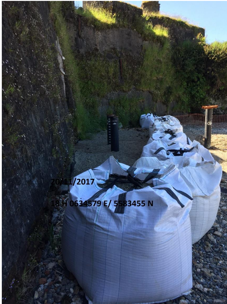
Imagen 40. Vista S hacia Medida Provisional de seguridad y control.
