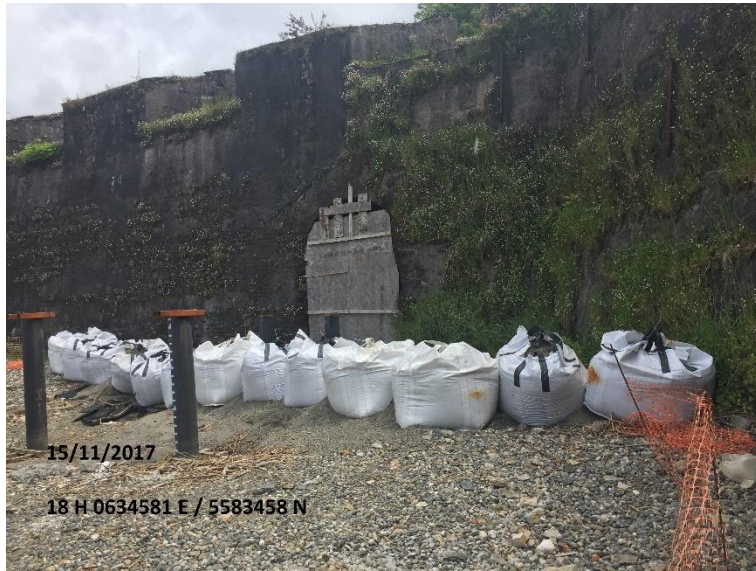
Imagen 30. Vista N hacia Medida Provisional de seguridad y control.
