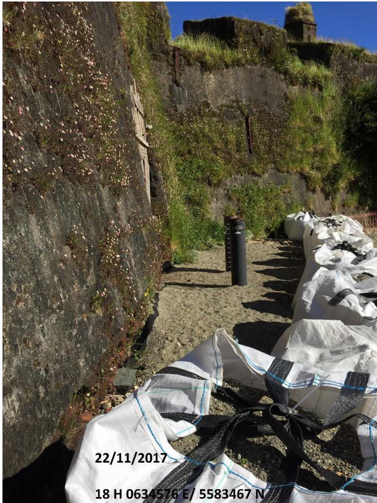
Imagen 43. Vista S hacia Medida Provisional de seguridad y control.
