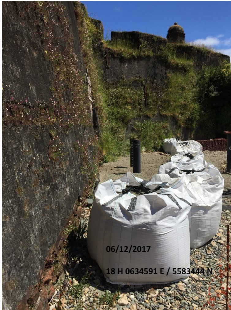
Imagen 67. Vista S hacia Medida Provisional de seguridad y control.
