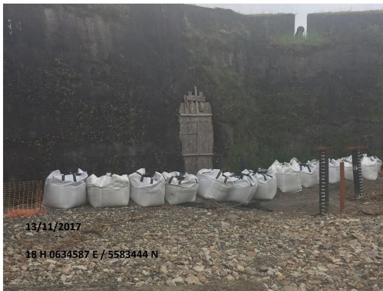
Imagen 25. Vista NE hacia Medida Provisional de seguridad y control.
