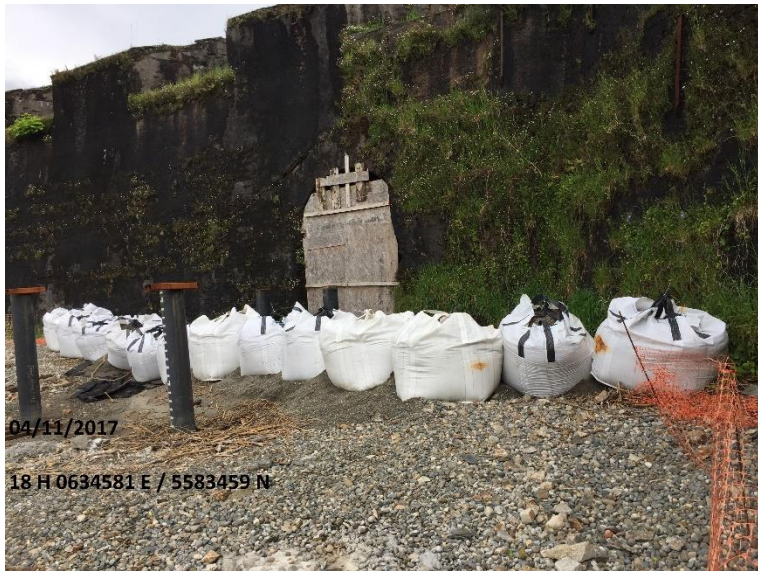
Imagen 11. Vista N hacia Medida Provisional de seguridad y control.
