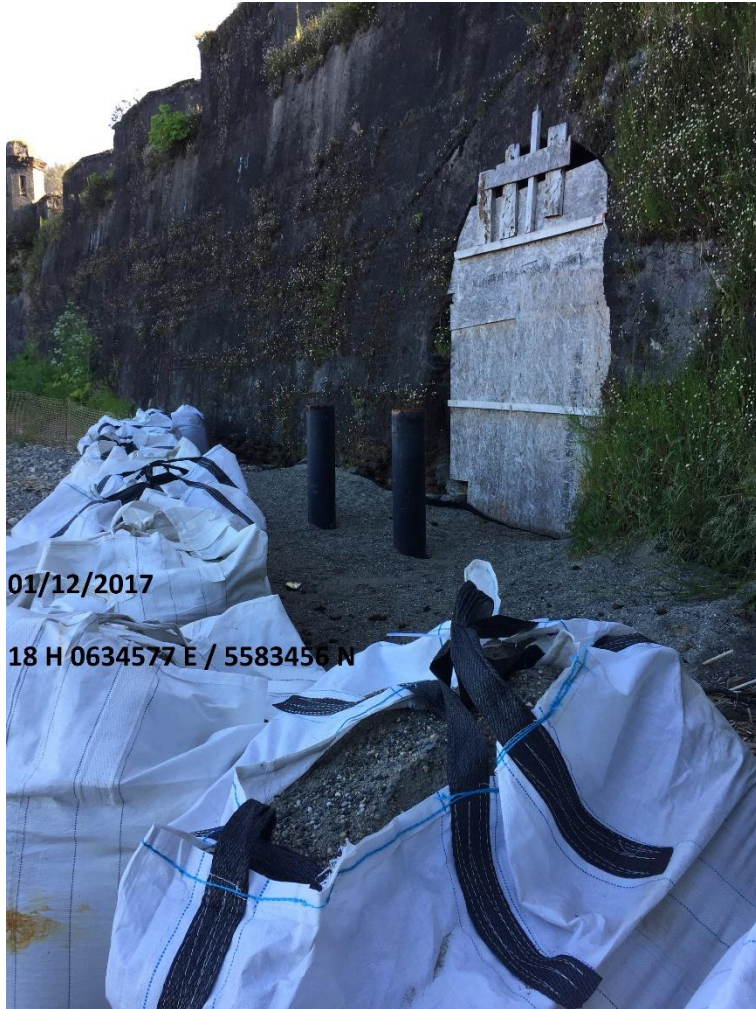
Imagen 58. Vista N hacia Medida Provisional de seguridad y control.
