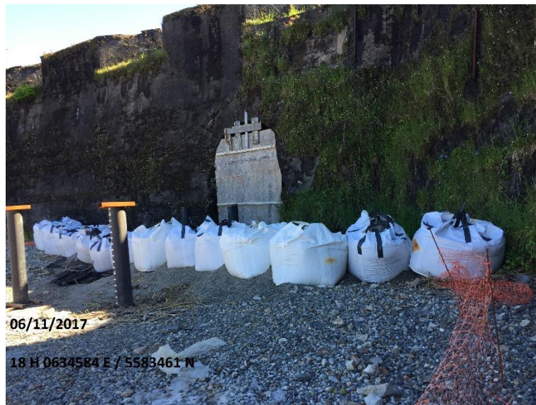
Imagen 15. Vista N hacia Medida Provisional de seguridad y control.
