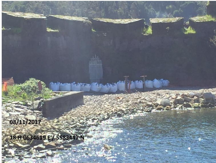
Imagen 17. Vista NE hacia Medida Provisional de seguridad y control.
