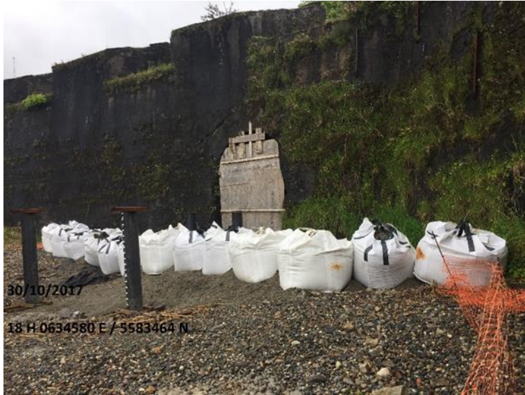
Imagen 2. Vista N hacia Medida Provisional de seguridad y control.
