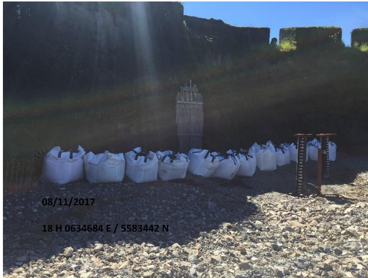
Imagen 20. Vista NE hacia Medida Provisional de seguridad y control.
