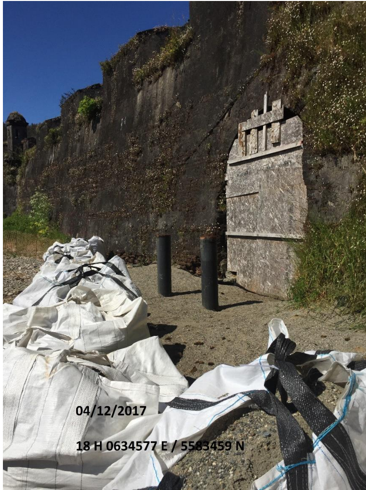
Imagen 62. Vista N hacia Medida Provisional de seguridad y control.
