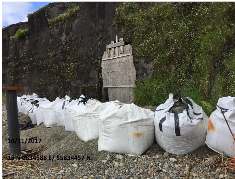
Imagen 34. Vista N hacia Medida Provisional de seguridad y control.
