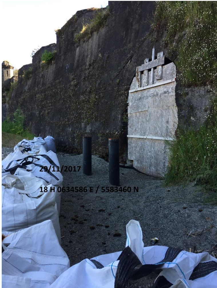
Imagen 55. Vista N hacia Medida Provisional de seguridad y control.
