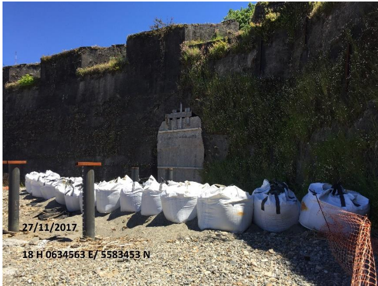
Imagen 49. Vista N hacia Medida Provisional de seguridad y control.
