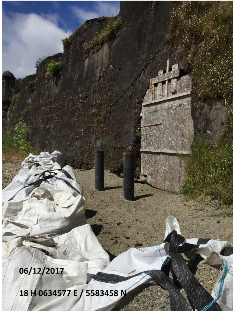
Imagen 66. Vista N hacia Medida Provisional de seguridad y control.
