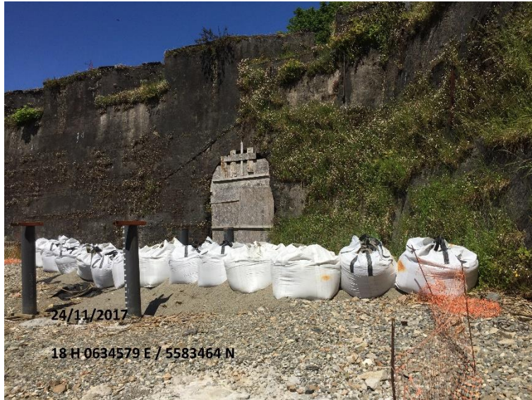
Imagen 46. Vista N hacia Medida Provisional de seguridad y control.
