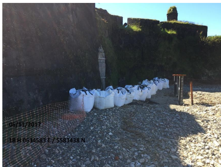
Imagen 16. Vista SE hacia Medida Provisional de seguridad y control.
