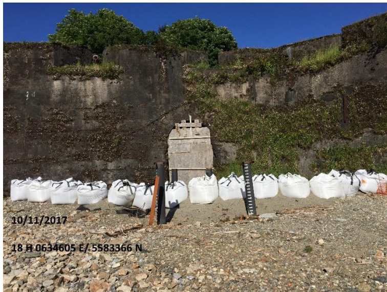
Imagen 21. Vista N hacia Medida Provisional de seguridad y control.
