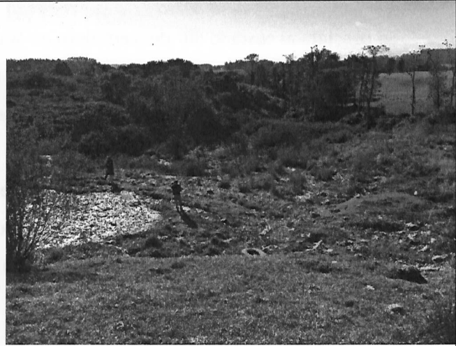
Fotografía N°12: Se observan líquidos lixiviados escurriendo hacia el norte del vertedero en dirección hacia estero sin nombre
