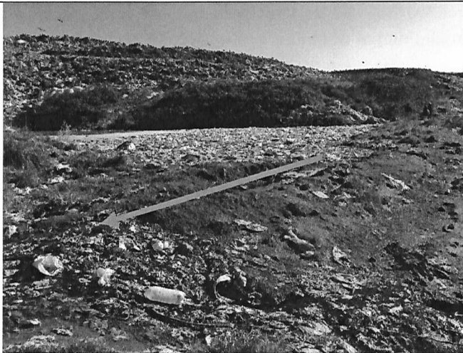
Fotografía N°11: Se observa el rebalse de los líquidos lixiviados desde la laguna aguas abajo hacia el sector norte del vertedero.
