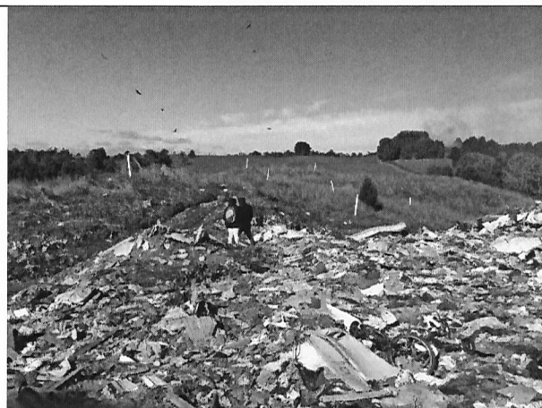
Fotografía N°16: Se observan tuberías de color blancas colocadas en superficie para extracción de gas
