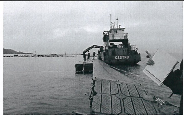
Fotografía N°5: Se observa embarcación realizando traslado de las estructuras.
