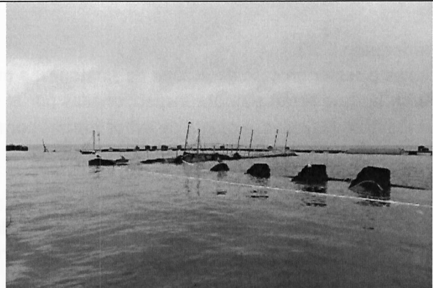
Fotografía N°2: Vista general lado norte del Centro de Cultivo, se observa partes de las estructuras del centro
