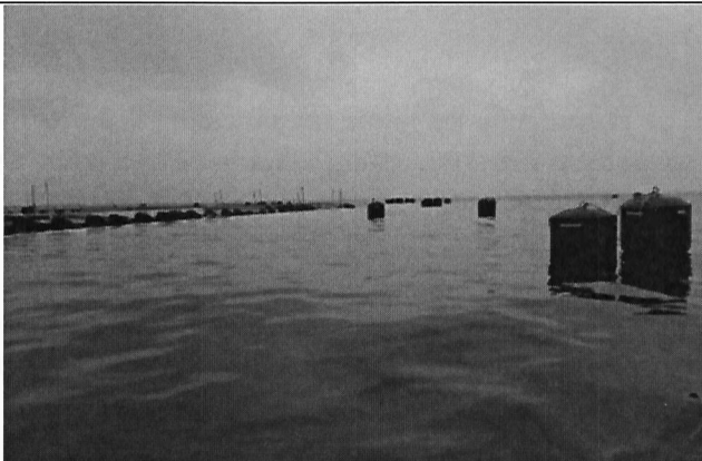
Fotografía N°1: Vista general lado Oeste del Centro de Cultivo, se observa partes de las estructuras del centro
