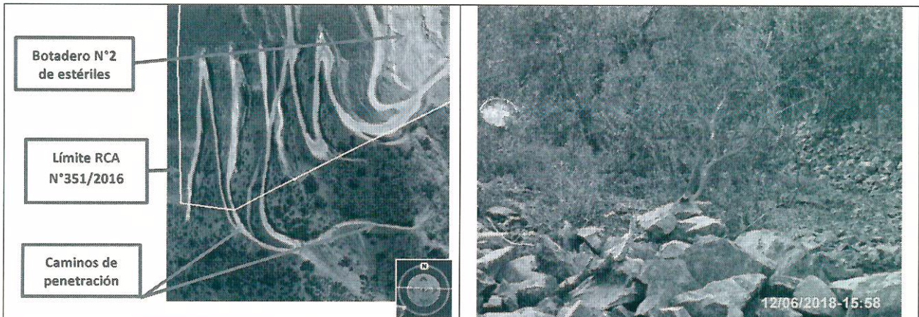
Figura 6: Se aprecia los caminos de penetración habilitados por el Titular en sector situado al sur del botadero N°2 de estériles, por sobre el límite del proyecto autorizado por la RCA N°351/2016
