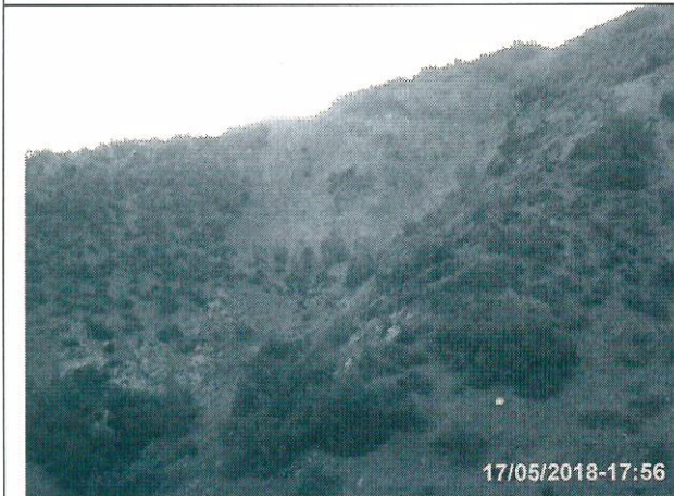
Fotografía 13: Vista de intervención de quebrada natural y obstrucción de su cauce, en ladera de cerro situada al sur del botadero N°2 de estériles.
