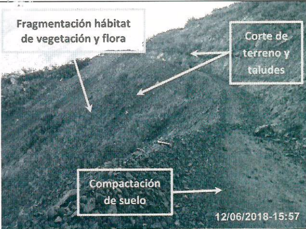
Fotografía 14: En la imagen se aprecia corte en la continuidad del terreno que constituye hábitat de vegetación y flora autóctona, taludes y compactación de suelo, en ladera de cerro situada al sur del botadero N°2 de estériles.
