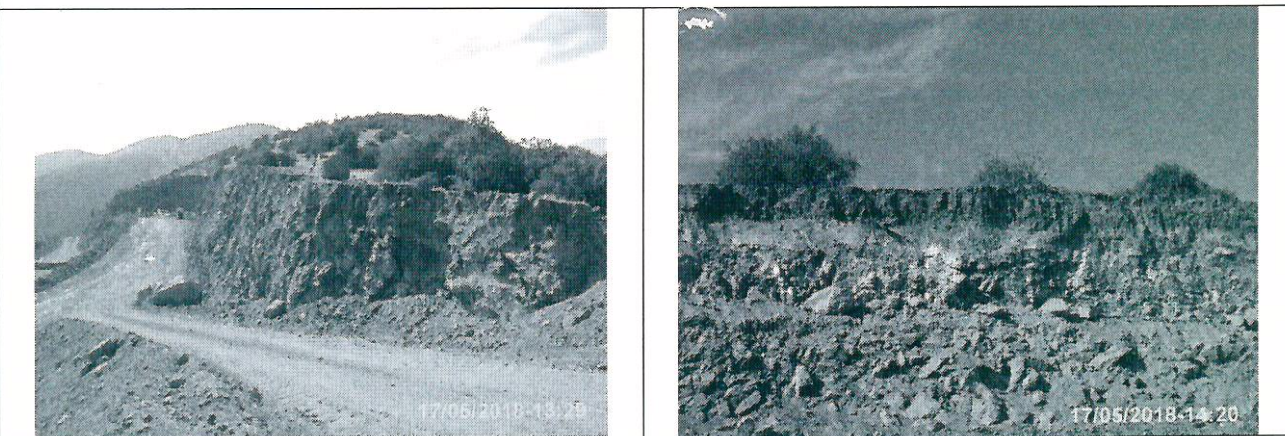
Fotografías 8 y 9: Cortes de terreno y de los límites autorizados en la RCA N°351/2016, en sector superior sur de desarrollo de la fase III.
