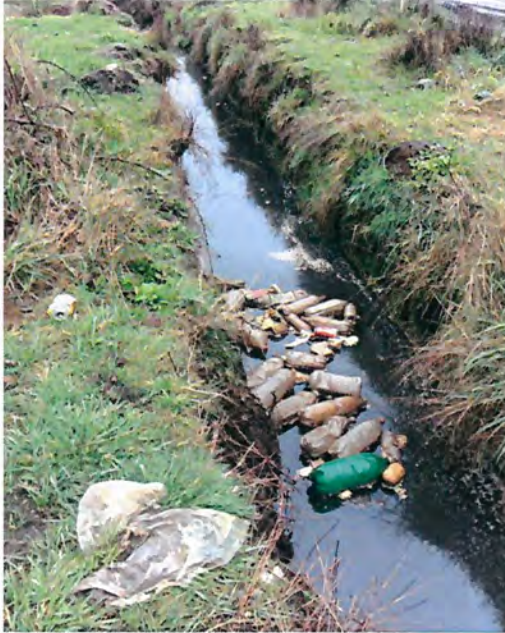
Fotografía N°10: Canal de aguas lluvias con lixiviados y residuos en la zona Noroeste.
