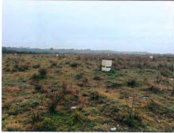
Fotografía N°18 y 19: chimeneas de venteo del biogás en las zonas antiguas del vertedero
