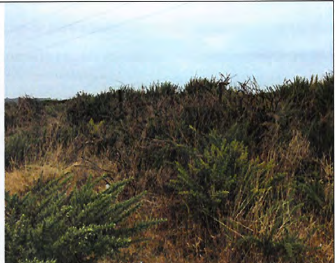
Fotografía N°3: Tramo del cierre perimetral sector Noreste cubierto con malezas
