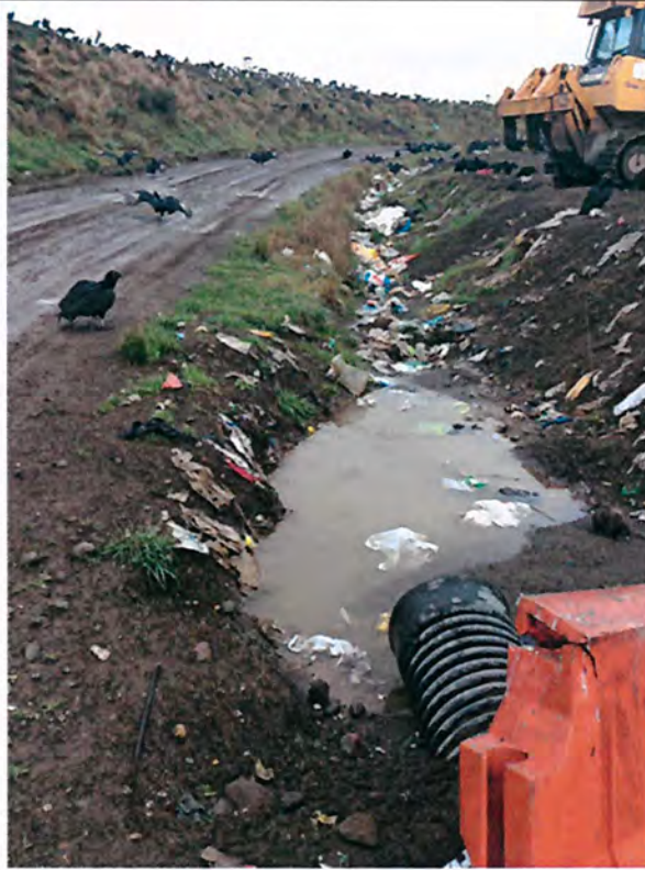
Fotografía N°4: Canal de aguas lluvias con residuos principalmente plásticos (Sector Norte), se observa tubería HDP corrugada.
