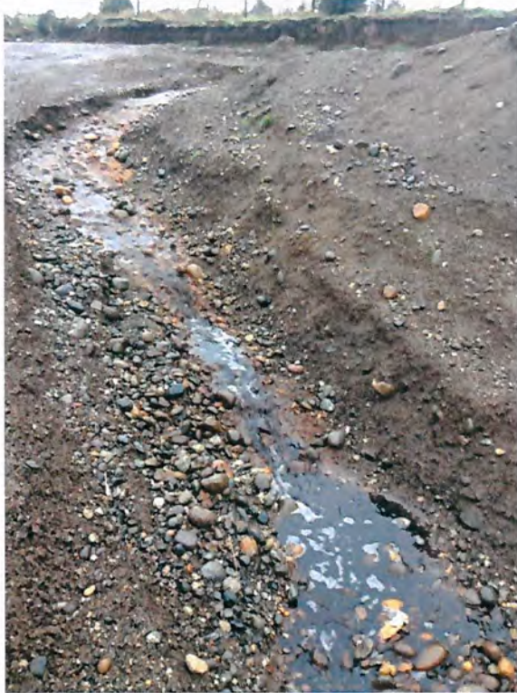
Fotografía N°12 y 13: Se observa escurrimiento y acumulación de lixiviados con aguas lluvias hacia el sitio de extracción de áridos, el cual se encuentra al Oeste del vertedero.
