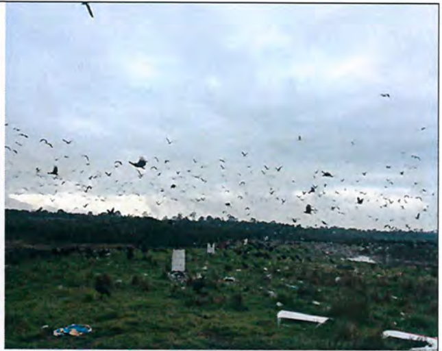
Fotografía N°19: Chimeneas de venteo del biogás, se observa gran cantidad de jotes y gaviotas (vectores).
