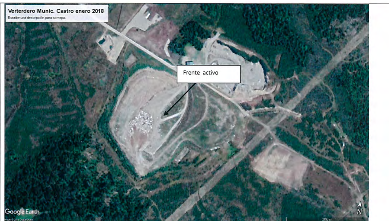
Imagen 27: Se Observa el avance del frente de trabajo en zona que el año 2011 se encontraba cerrada
