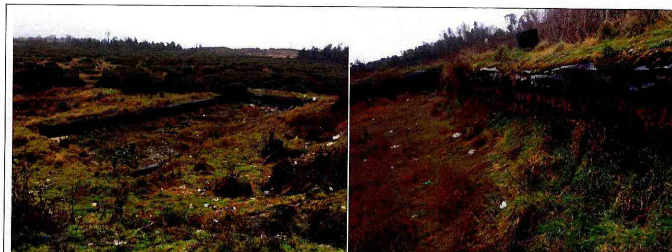
Fotografía N°11: Lugar donde estuvo la estructura de la piscina de lixiviadas del sector Este.
