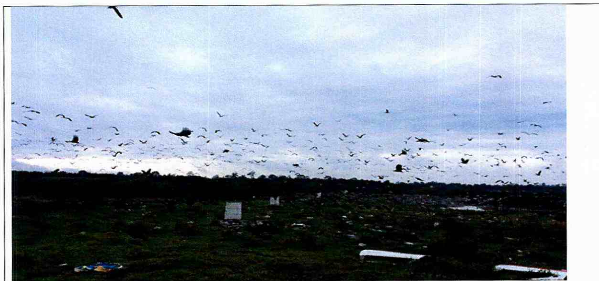
Fotografía N°6: Chimeneas de venteo del biogás, se observa gran cantidad de jotes y gaviotas (vectores).
