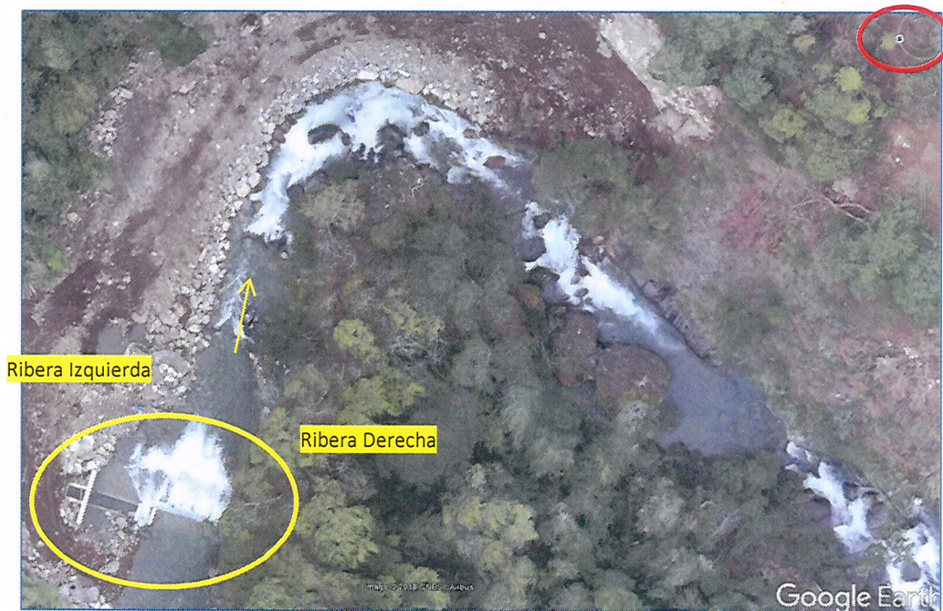
Imagen N°4. Obra de bocatoma construida en estero Nacimiento.
