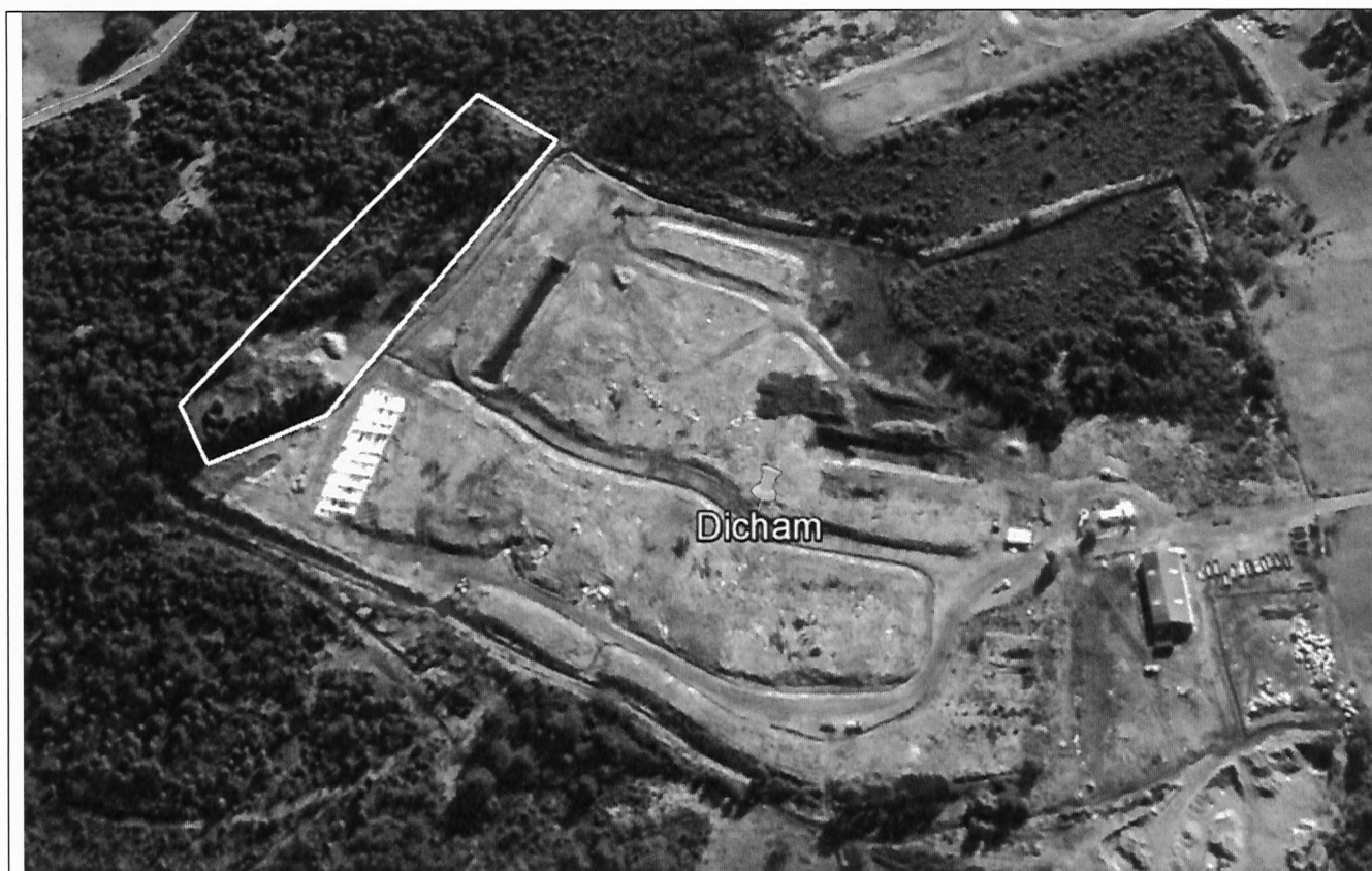
Imagen N° : En color blanco polígono lado oeste del vertedero, donde se acumularon líquidos lixiviados.
