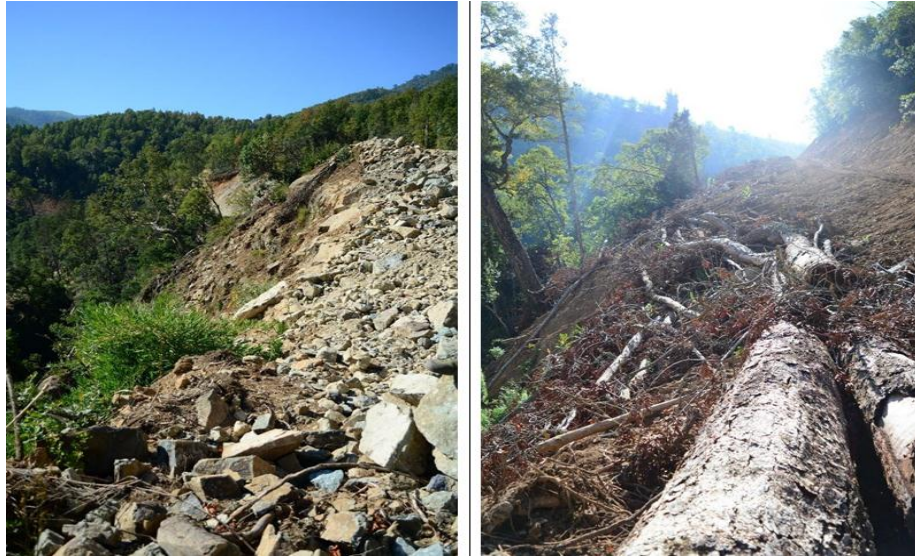
Fotografías 13 y 14. Sector con pendiente aproximada de 70%, dónde se presentan acopiados materiales de tipo rocoso y vegetal.
