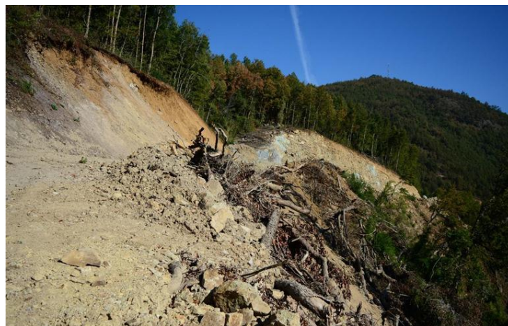
Fotografía 17. Sector con pendiente aproximada de 70%, dónde se presentan acopiados materiales de tipo rocoso y vegetal.
