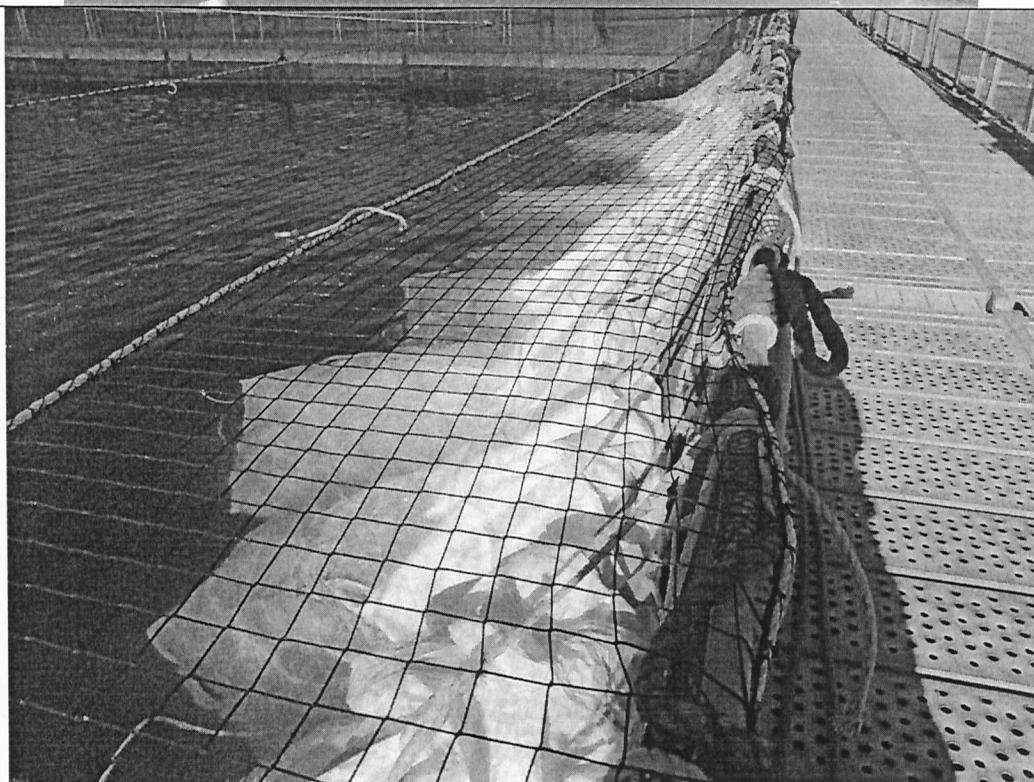
Imágenes obtenidas al momento de la Inspección.
