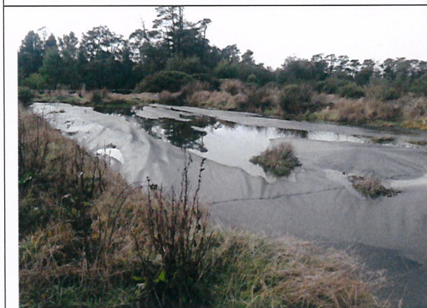
SET de Fotografías con Imágenes de las otras zanjas con geomembrana con líquido mezclado con lodos de su interior de la zanja.
