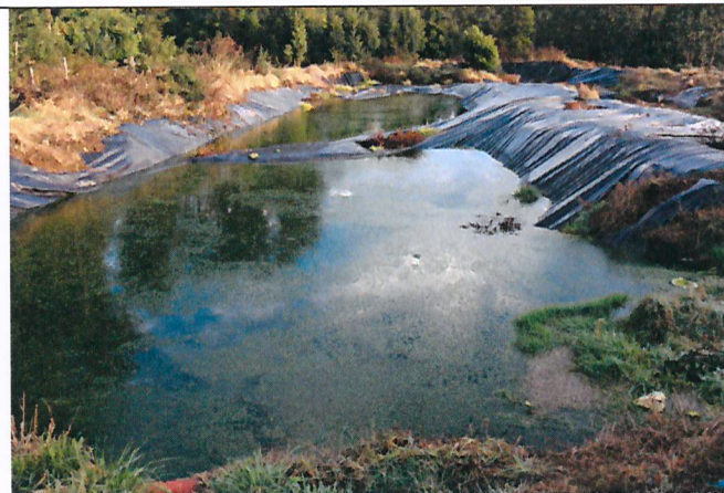
SET de Fotografías con Imágenes de las otras zanjas con geomembrana con líquido mezclado con lodos de su interior de la zanja.
