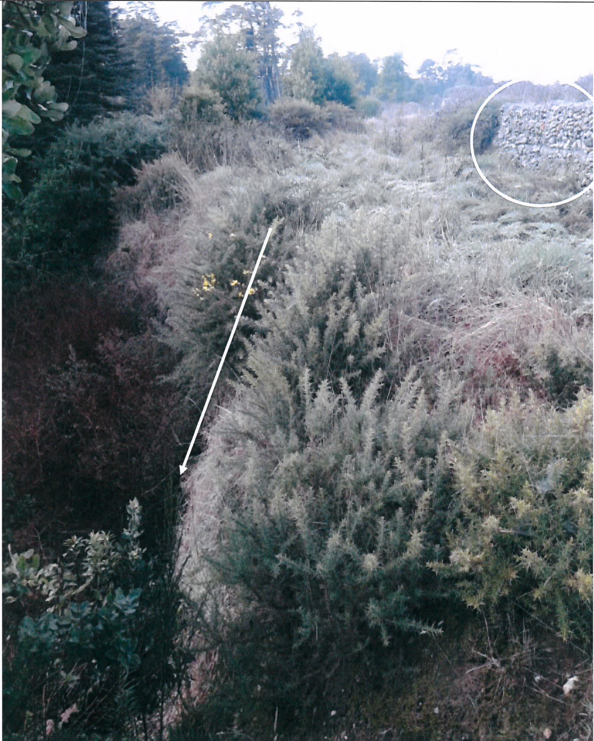
Fotografía 3: Características del terreno en el sector de quebrada, donde se aprecia una pendiente escarpada. Al costado derecho se ven los gaviones que delimitan y contienen la zona de zanjas con la quebrada.
