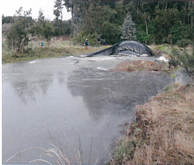
Fotografía 7: Zanja en mal estado con acumulación de biogás.
