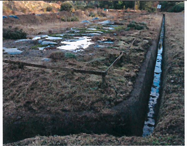
Fotografía 5: Sistema de canalización de aguas lluvias de zanjas al inicio del predio.
