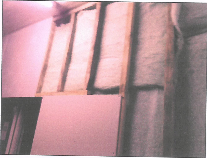
Revestimiento de Tabique con plancha de yeso carton de 10 mm, con sistema Acústico Politerm instalado.
