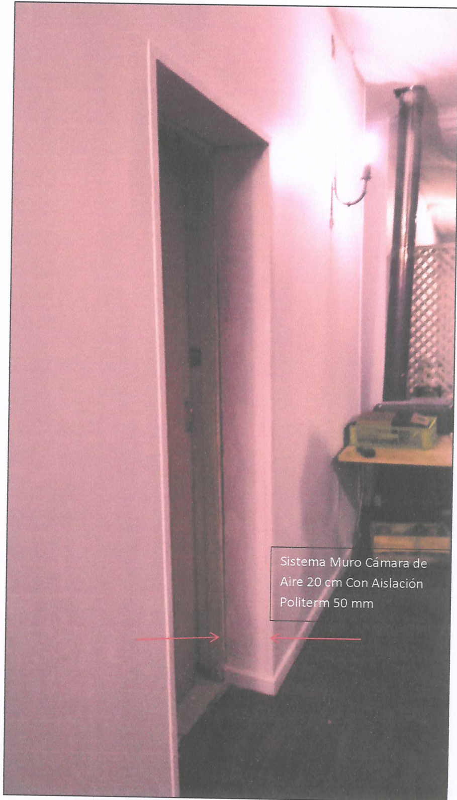
Pared de cámara de aire con sistema acústico Politerm terminada
