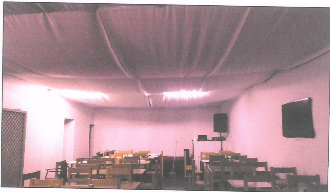
Paredes y Cielo raso terminado con sistema acústico Politerm y telas
