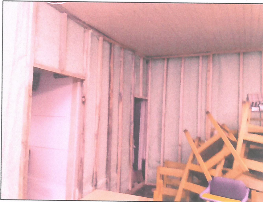
Instalación de sistema acústico Politerm en tabiquería autoportante
