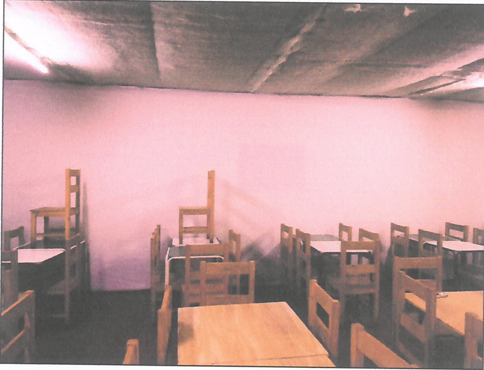
Sistema Acústico instalado en cielo raso
