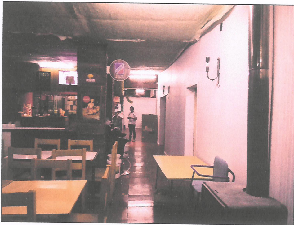
Sistema Acústico instalado en cielo raso
