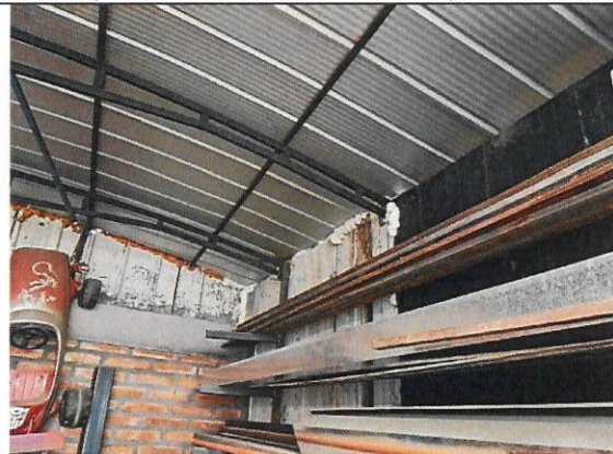
Foto No 3 Muro medianero oriente aislado con placa de Aislapol de 14 cm de espesor.
