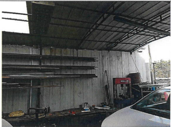
Foto No 3 Muro medianero oriente aislado con placa de Aislapol de 14 cm de espesor.
