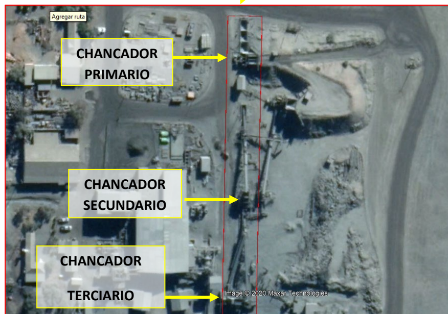
Imagen N°1: Mapa esquemático de los lugares en que se ejecutaron los trabajos correctivos en los chancadores secundario y terciario de la Línea de Chancado N° 2.
