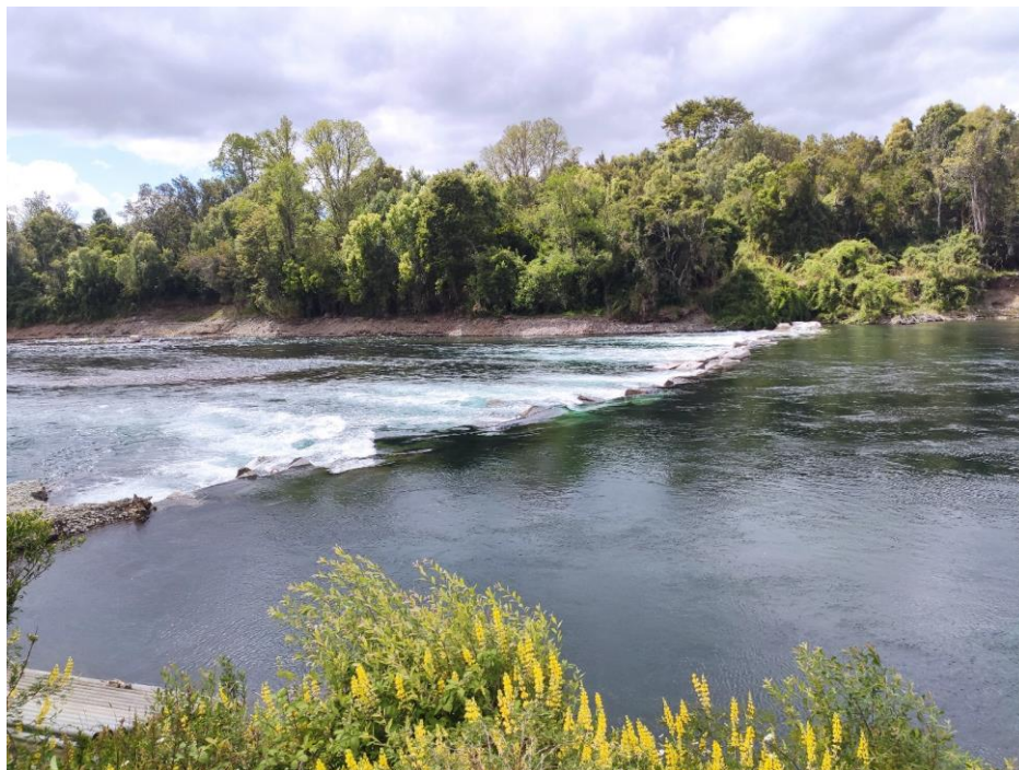
Figura 3-3: Barrera de Captación de Derechos en Bocatoma Piscicultura Copihue
