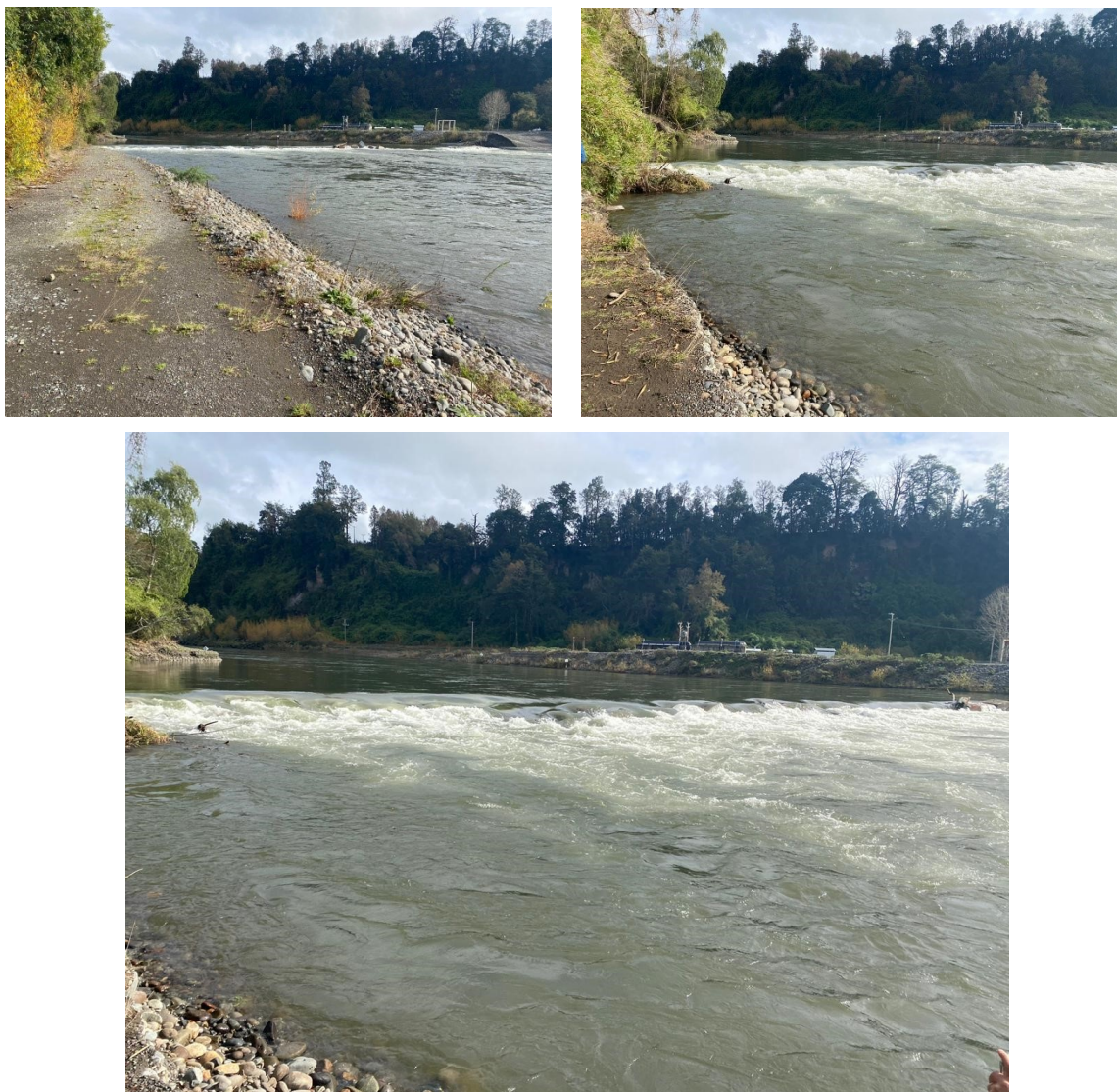
Figura 20 Fotografías relleno construido por la piscicultura tomadas durante la Auditoría Ambiental Mayo 2020
