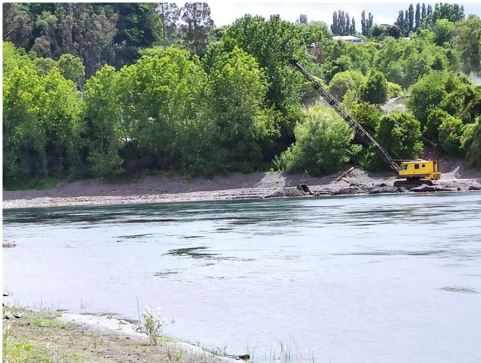
Figura 3-6: Río Rahue, maquinaria Dowling & Schilling extrayendo áridos en la orilla derecha
