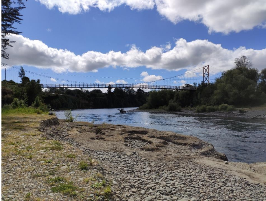
Figura 3-1: Vista del Río Rahue hacia Aguas Arriba del Puente en Ruta U-55-V (aguas arriba del tramo intervenido)
