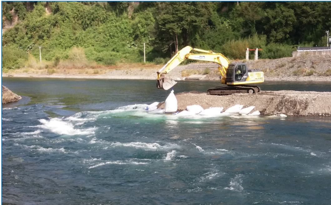
Figura 5: Intervención Aquafarms (modificación de cauce no autorizada) con maxisacos rellenos (Ene/Feb 2019)
