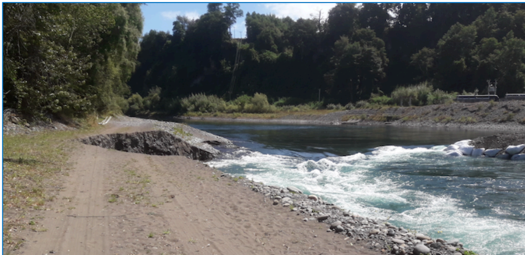
Figura 6: Erosión y corte de terraplén en ribera norte, producto del estrangulamiento del río efectuado por Aquafarms (Ene/Feb 2019)
