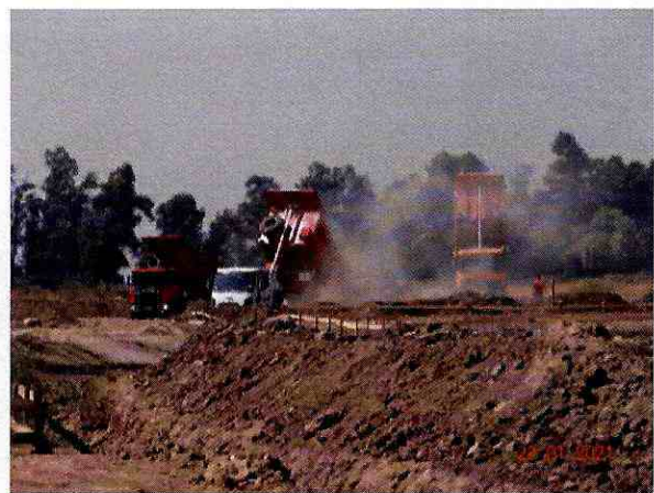
Figura N°5: descarga de material sector sur loteo
