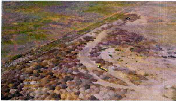
Figura N°6: camión camino a depositar fuera del loteo
