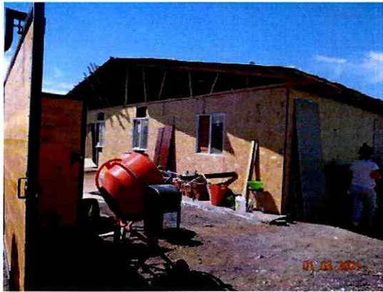
Figura N°11: Construcción de vivienda
