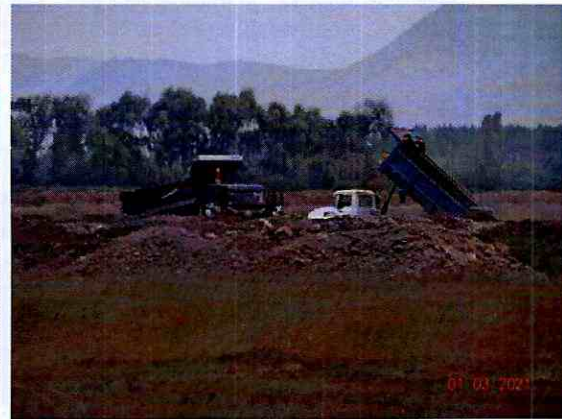
Figura N°16: Descarga de camiones
