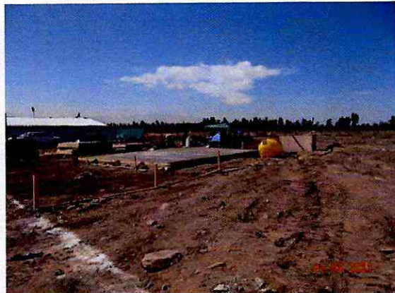
Figura N°10: construcción de radieres
