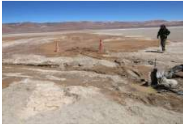
Figura 6. - Vestigios de escurrimiento de agua superficial hacia la Laguna del Negro Francisco producto de las perforaciones realizadas por el Titular. En imagen se observa área alrededor de sondaje N° 2.
