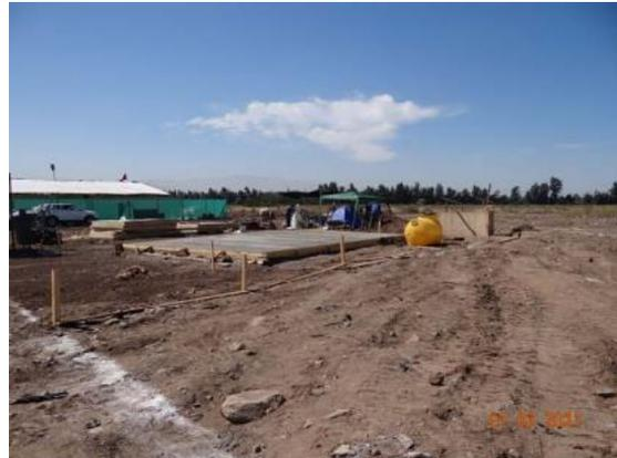
Figura N°10: construcción de radieres
