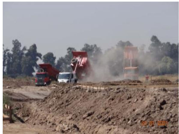
Figura N°5: descarga de material sector sur loteo
