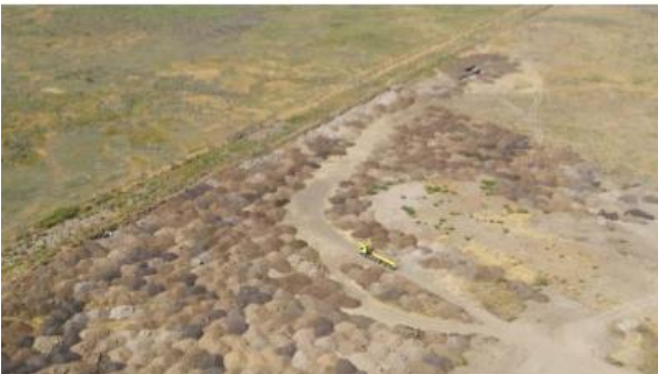
Figura N°6: camión camino a depositar fuera del loteo
