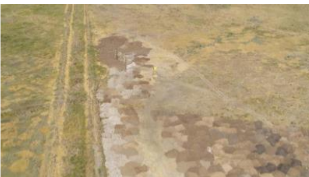
Figura N°8: camión camino a depositar fuera del loteo
