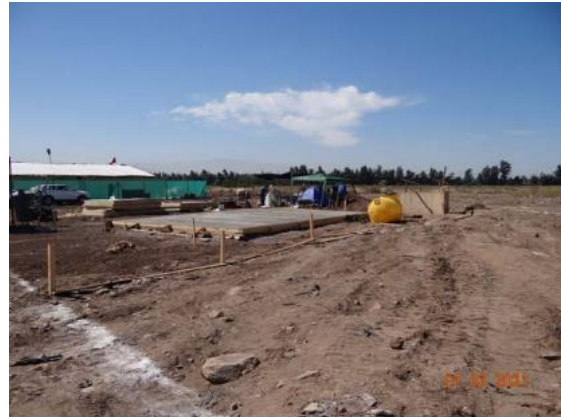
Figura N°10: construcción de radieres
