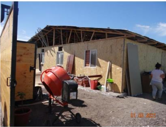
Figura N°11: Construcción de vivienda
