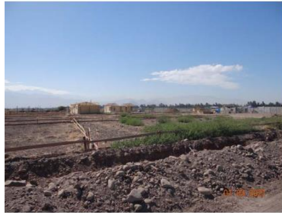
Figura N°12: Cierres y construcciones
