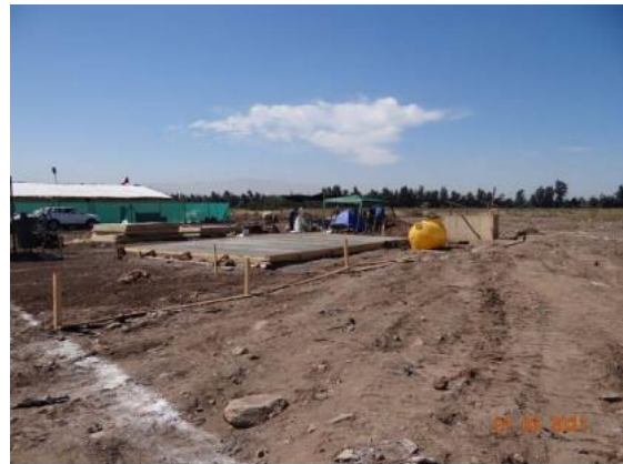
Figura N°10: construcción de radieres
