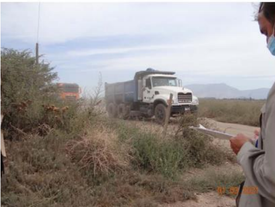
Figura N°15: Salida de camiones sin carga
