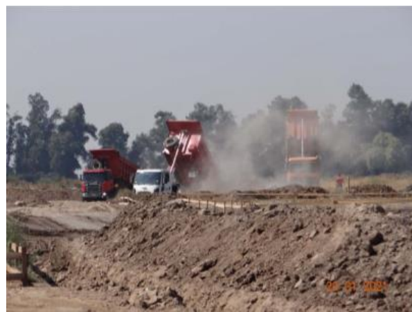
Figura N°5: descarga de material sector sur loteo
