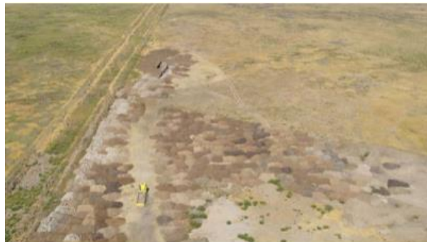
Figura N°7: camión camino a depositar fuera del loteo
