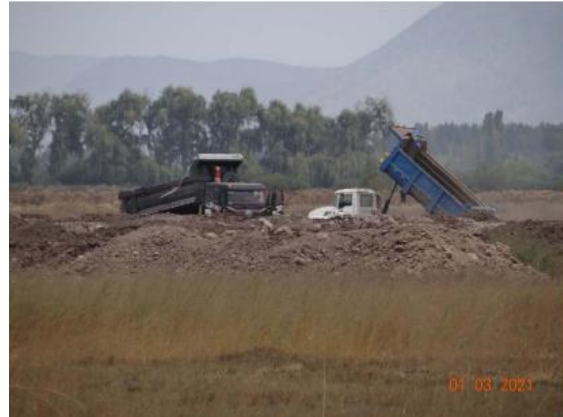
Figura N°16: Descarga de camiones
