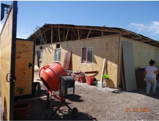
Figura N°11: Construcción de vivienda
