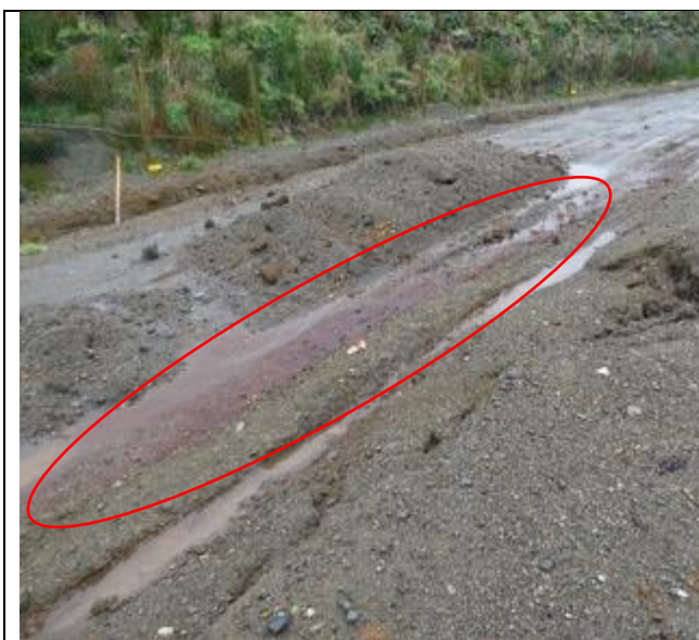
Fotografía N°12: Se constata lixiviados en lado Este.
