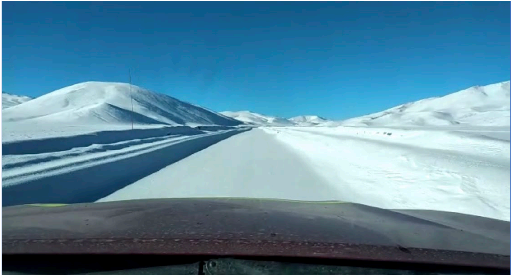
Ruta C-607 (actualmente enrolada como C-347); Km 2,5 (aprox.). en cercanías de intersección rutas C-601 y C-607 Fecha 29-06-2021
