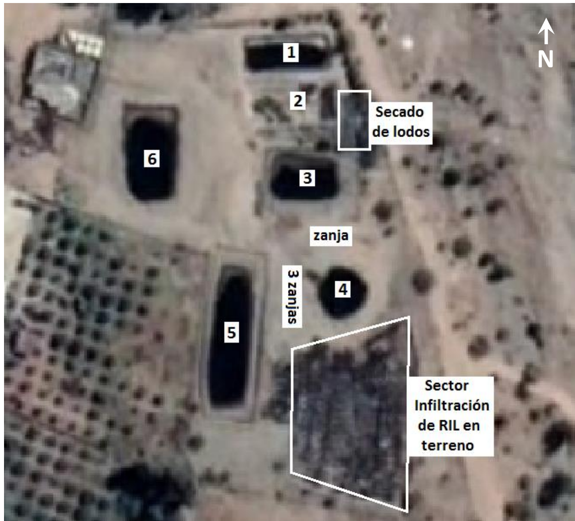
Figura 2. Zona de disposición final. Piscinas de acumulación enumeradas, zona donde se ubican las zanjas, sector de secado de lodos y sector de infiltración de RIL en terreno (Fuente: Google Earth 2021, fechas de imágenes: 10/06/2020).
