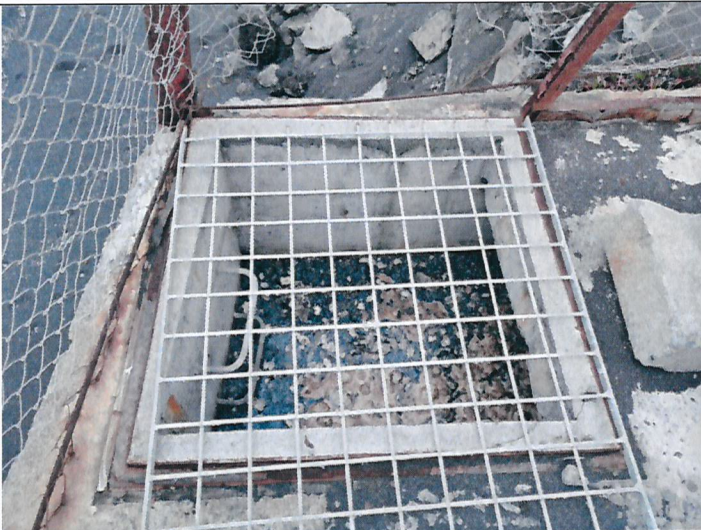
Fotografía N°11: Pozo de decantación 3.
