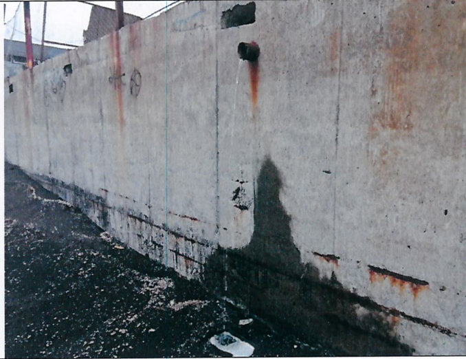
Fotografía N°4: Descarga de riles desde la Planta.
