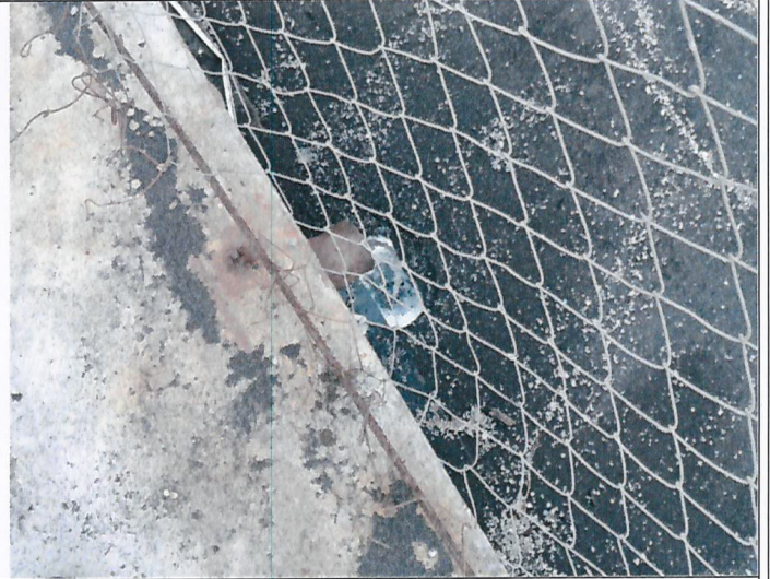
Fotografía N°12: Punto de descarga Pozo decantación 3.
