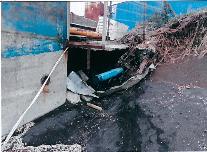
Fotografía N°3: Ducto cerrado, desde donde se denunció la descarga de Riles por parte de la Armada.
