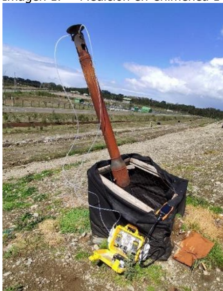
Imagen 17 – Medición en Chimenea 1
