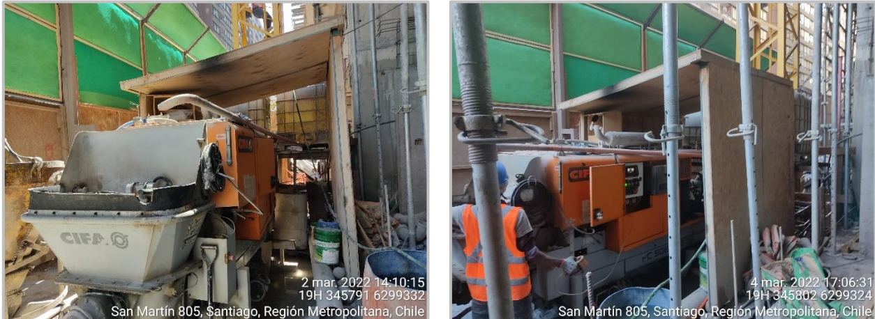
Figura 6: Semi-encierro bomba de hormigón.
