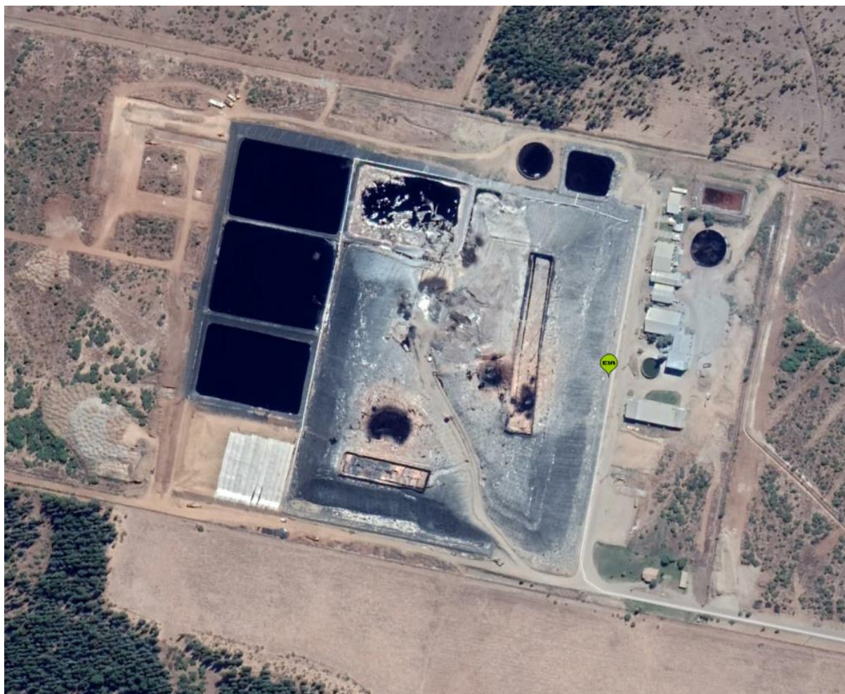
Figura 3. Layout del proyecto (Fuente: Google earth Pro , 2016 de fecha 16.03.2019) Centro Integral de Tratamiento Ambiental (CITA) ECOBIO
