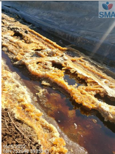
Foto 12 fuga lixiviados zona sur CITA 16.05.2022
