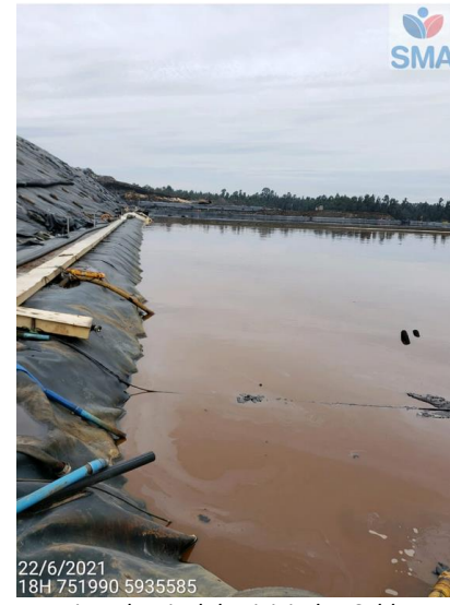
Foto Vista de Nivel de Lixiviados Celda 4.1.A.
