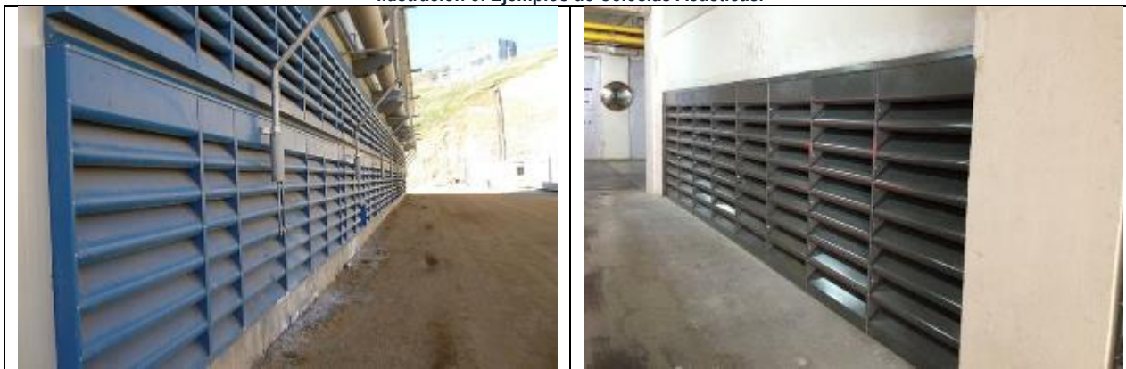
Ilustración 5: Ejemplos de Celosías Acústicas.
