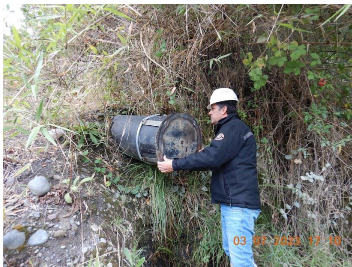
Fotografía 6: Jefe regional SMA, constatando sello y hermeticidad de la tubería.
