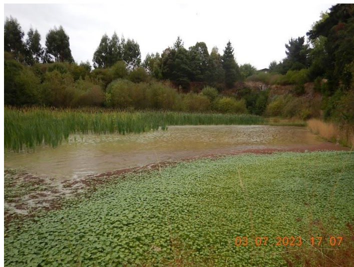
Fotografía 4: La piscina N°5, ubicada previo a la descarga, con evidente baja en el nivel de agua, en relación a inspecciones anteriores, producto de la paralización de la planta. No se observaron aportes de ningún tipo a esta piscina.
