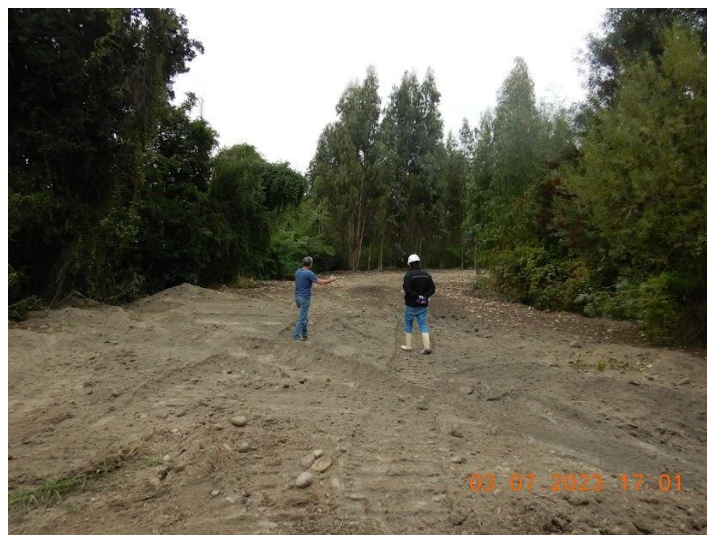
Fotografía 2: Sector de piscina N°4, tapada, sin operación.
