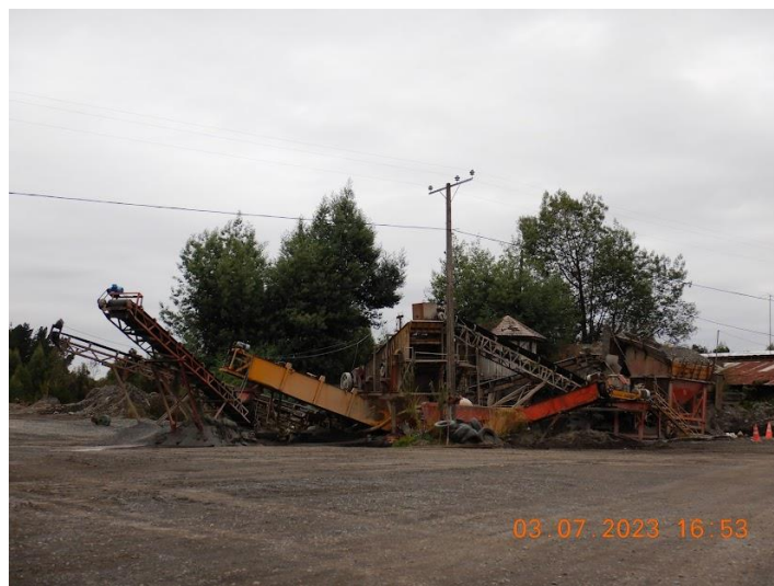
Fotografía 1: Planta de áridos detenida, sin funcionamiento, al momento de la inspección.
