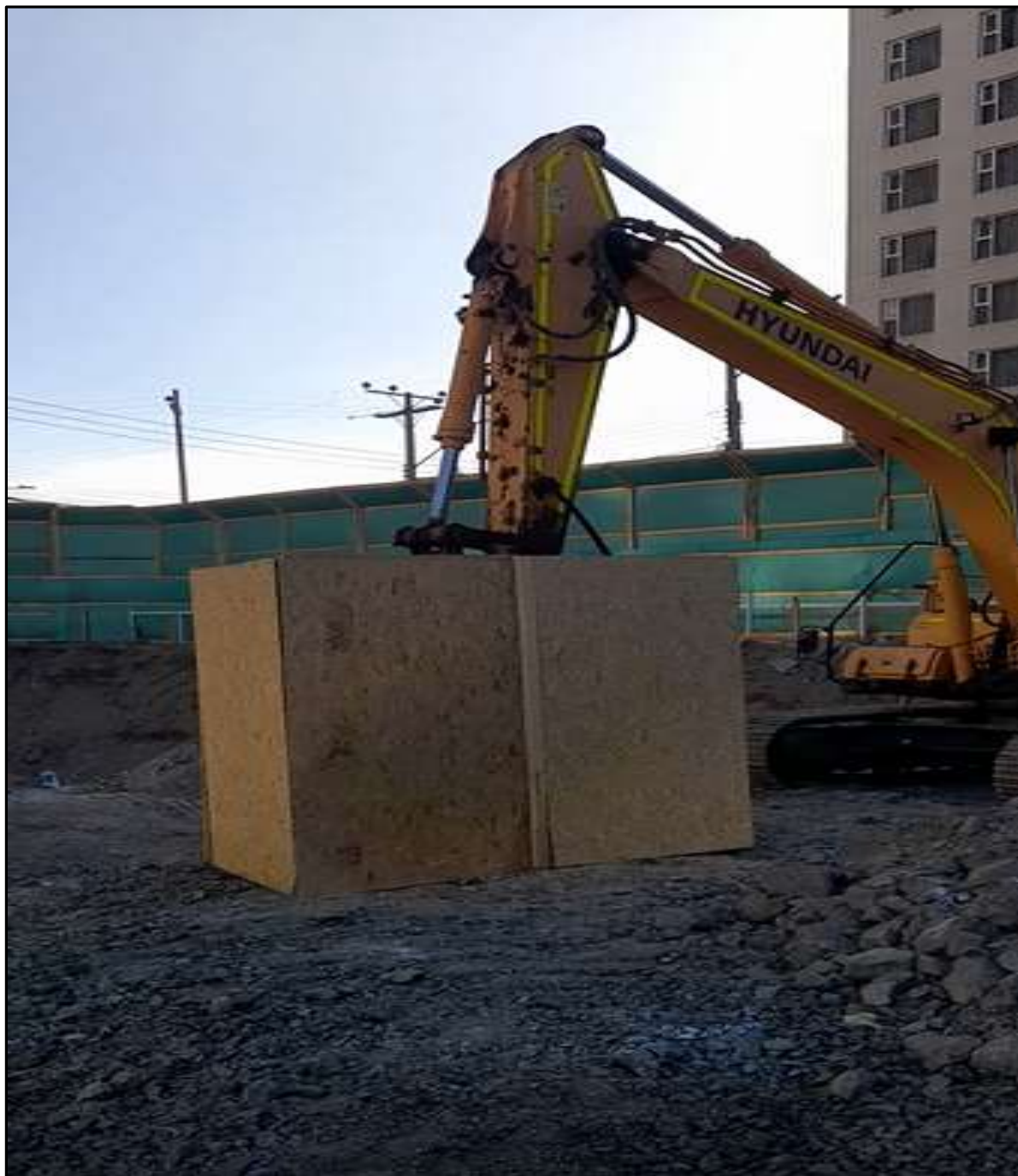
Imagen de prueba donde se implementa biombo acústico para martillo hidráulico
