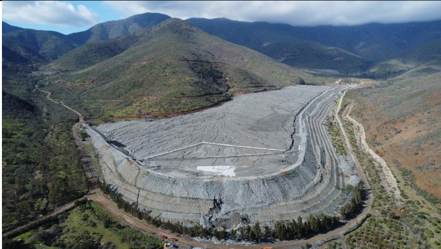
Imagen N°23. Reparación Muro Depósito en Pasta
