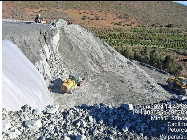
IMAGEN N° 19. TRABAJOS EN SEGUNDA ETAPA DE RELLENO Y COMPACTACIÓN DEL MURO.
