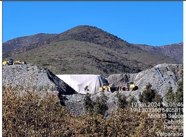
IMAGEN N° 20. TRABAJOS EN SEGUNDA ETAPA DE RELLENO Y COMPACTACIÓN DEL MURO
