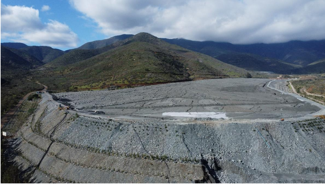
Imagen N°24. Reparación Muro Depósito en Pasta
