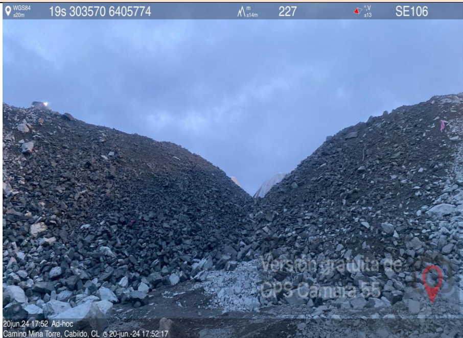
IMAGEN N° 21. TRABAJOS EN SEGUNDA ETAPA DE RELLENO Y COMPACTACIÓN DEL MURO
