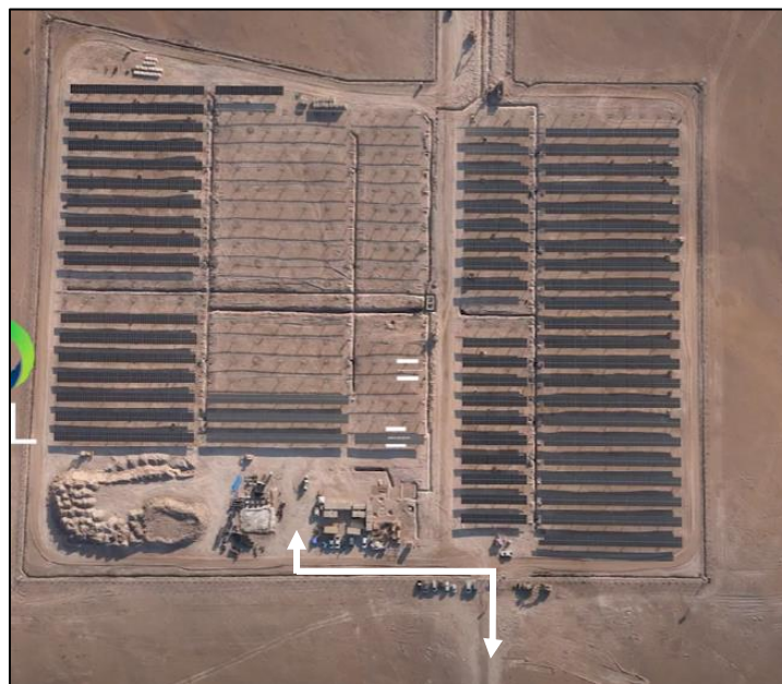
Figura 3: Ruta de Ingreso y salida de Camión Pluma
