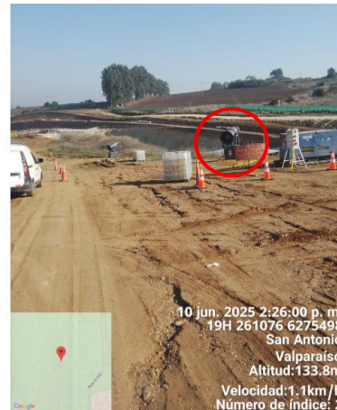
Figura: Coberturas de geotextil (cubierta de color blanco) y nebulizadores (identificado con un círculo rojo) en la tronadura del 10 de junio de 2025
