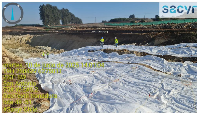
Figura: Coberturas de geotextil (cubierta de color blanco) y nebulizadores (identificado con un círculo rojo) en la tronadura del 10 de junio de 2025
