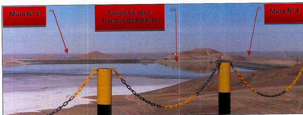
Figura 1. Laguna de aguas claras formada entre los muros 3 y 4 del depósito de relaves. Fecha 10 de septiembre de 2015.
