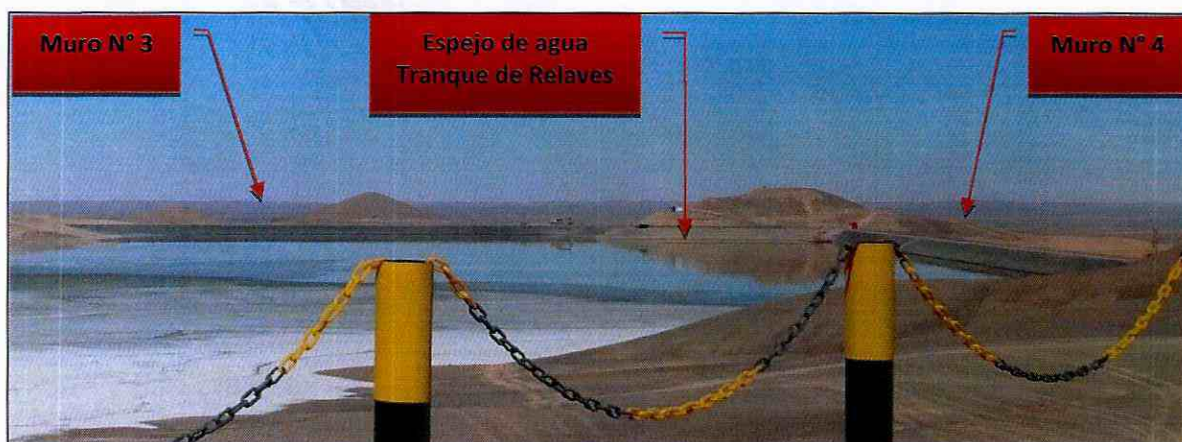
Figura 1. Laguna de aguas claras formada entre los muros 3 y 4 del depósito de relaves. Fecha 10 de septiembre de 2015.
