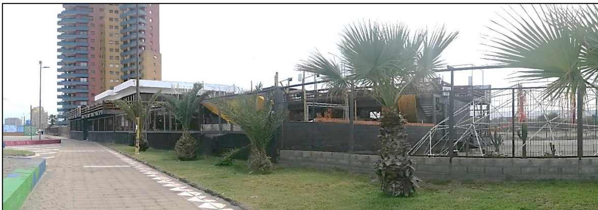
Figura 5: Vista de flanco sur: Muro medianero y rejas metálicas.
