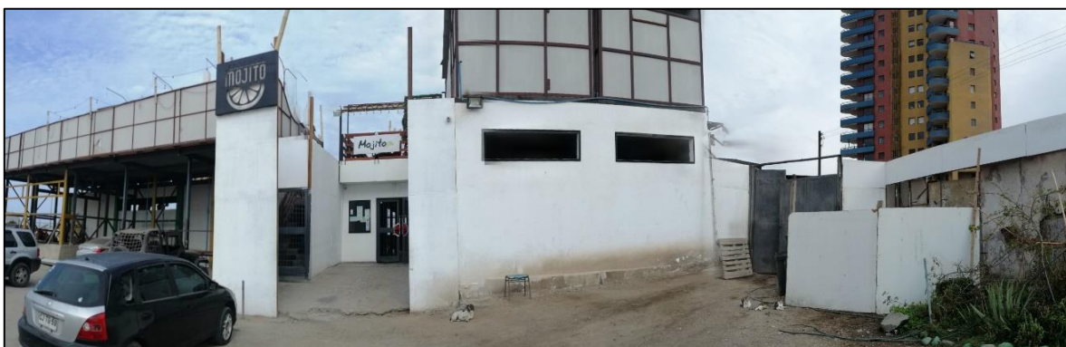
Figura 6: Vista de flanco este: Fachada con muro de hormigón, reja metálica y fibrocemento.
