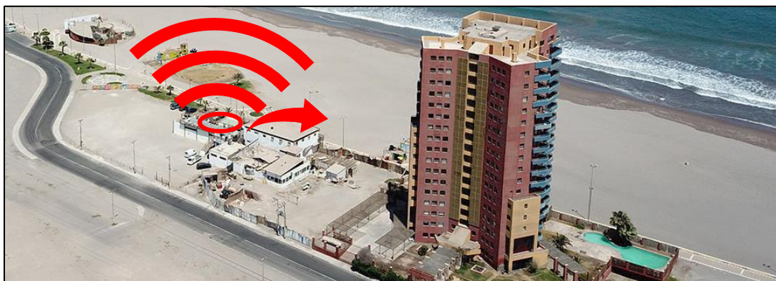
Figura 8: Vista de aérea: efecto de difracción y sombra acústica en edificio.
