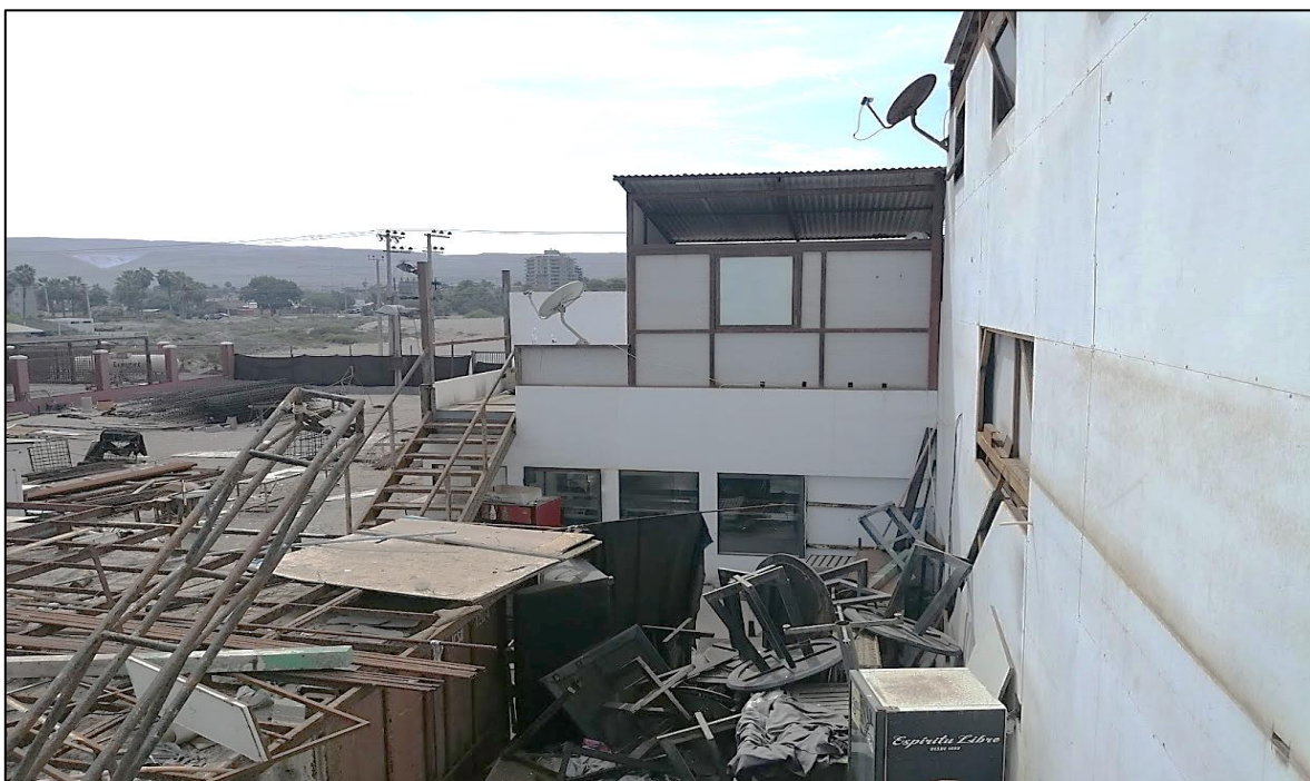
Figura 4: Vista de flanco norte segundo piso: Estructura metálica con planchas de fibrocemento.
