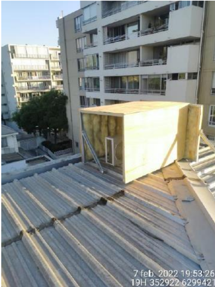
Figura 4. Semiencierros acústicos a cajas de aire acondicionado con material fonabsorbente en su interior (uno con lana mineral, a la izquierda, y otro con espuma acústica, a la derecha).
