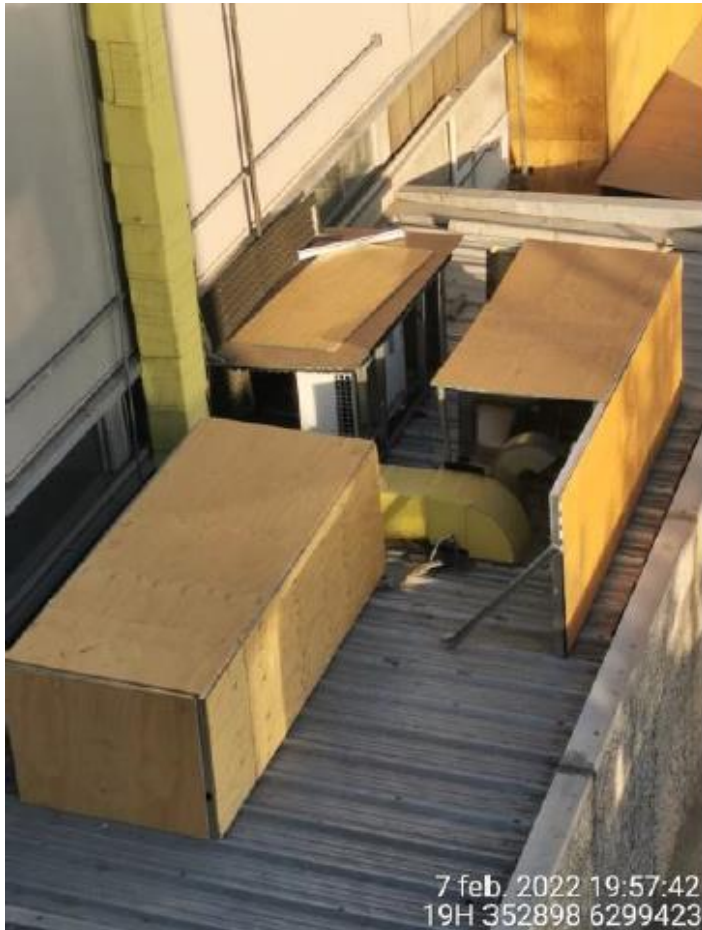
Figura 6. Semiencierros acústicos a equipos de aire acondicionado y extractores (izquierda) y semiencierros acústicos a unidades condensadoras (derecha). Según señala la ETFA, los semiencierros acústicos se encuentran conformados por placas de terciado de 15 mm de espesor y en su interior revestidos con lana mineral de 60 mm.
