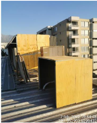
Figura 1. Semiencierro acústico con placa de terciado y material fonoabsorbente (espuma acústica) al interior para los equipos AC y extractor de aire.
