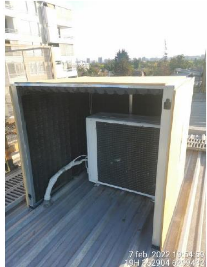
Figura 4. Semiencierros acústicos a cajas de aire acondicionado con material fonabsorbente en su interior (uno con lana mineral, a la izquierda, y otro con espuma acústica, a la derecha).
