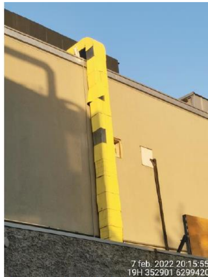
Figura 5. Semiencierro acústico a extractores (izquierda) e izado y encamisado al ducto de extracción de aire (derecha).
