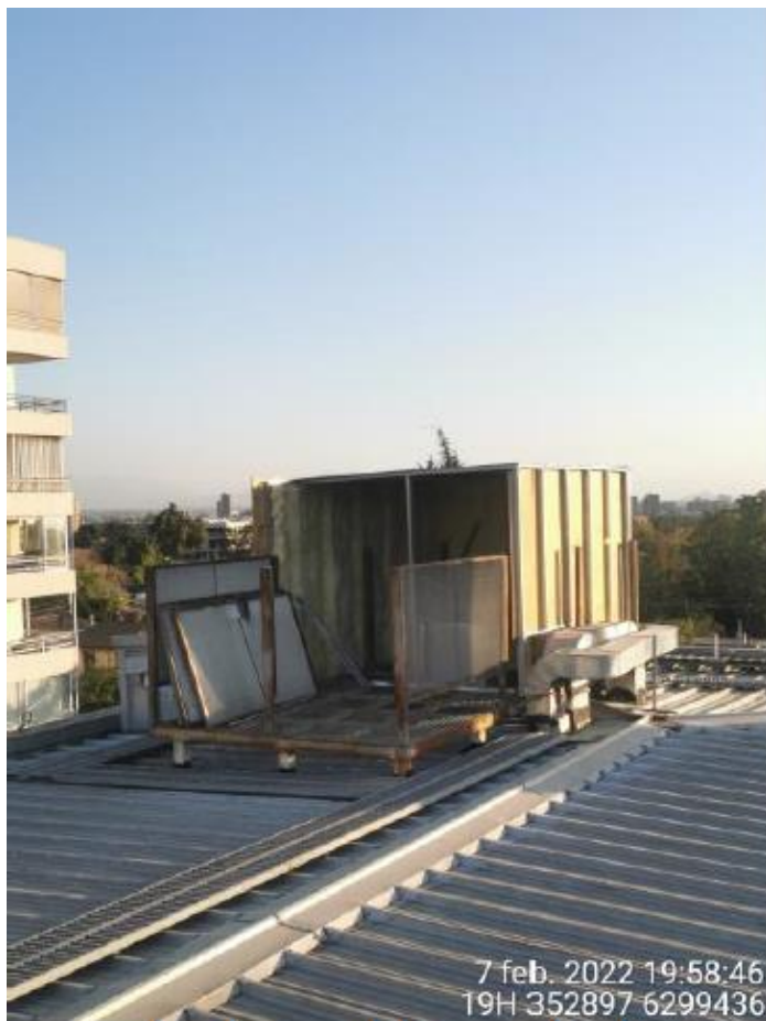
Figura 5. Semiencierro acústico a extractores (izquierda) e izado y encamisado al ducto de extracción de aire (derecha).
