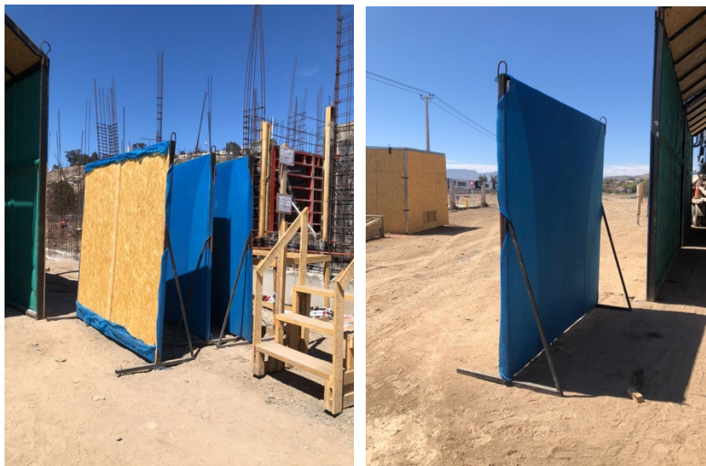
Figura 5 – Registro fotográfico de Biombo Acústico
