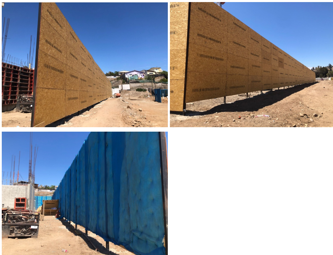
Figura 6 – Registro fotográfico Pantalla Acústica perimetral
