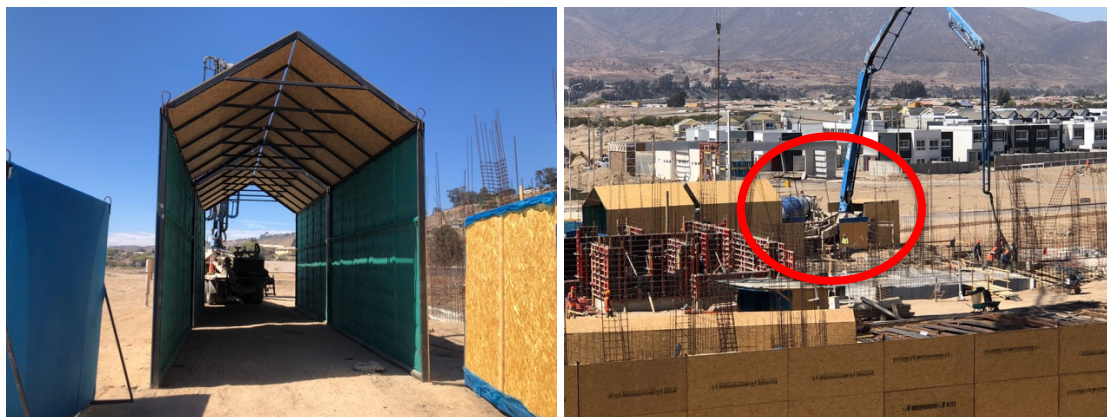
Figura 1 – Registro fotográfico de Túnel acústico camiones Mixer y bomba de hormigonado
