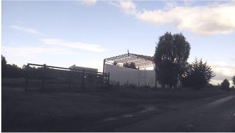
Imagen 3 > Construcción de frigorífico de lácteos Paillahue Ltda.
