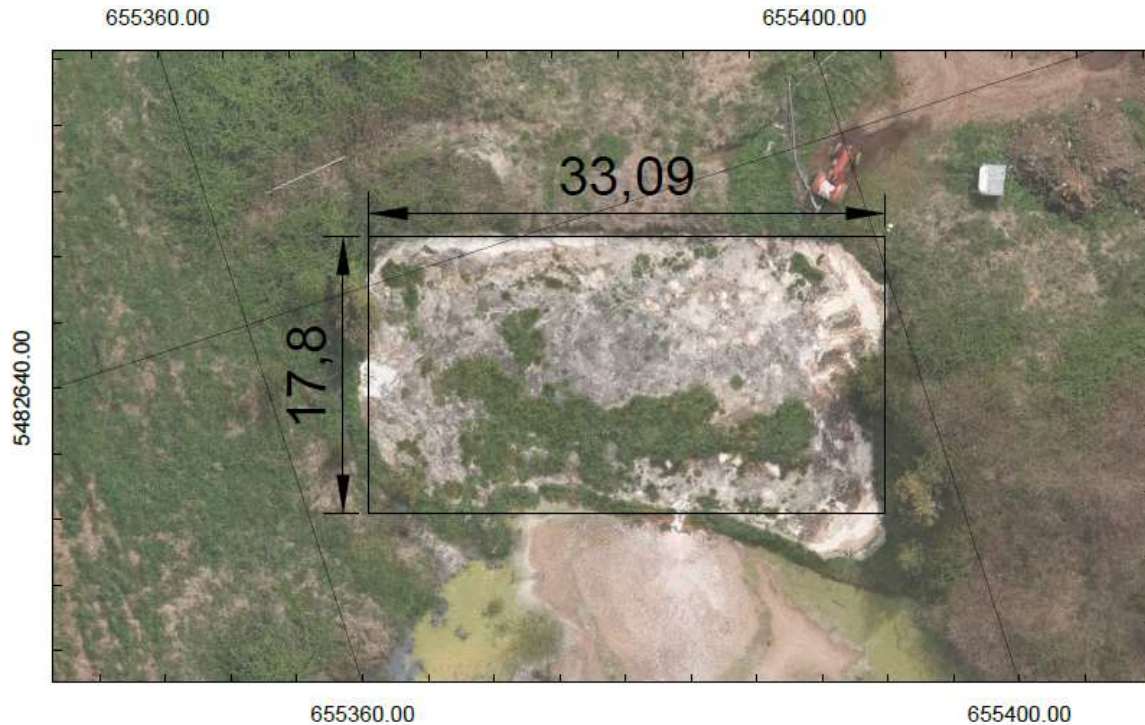
Figura 1: Vista estanque acopio RIL a riego
