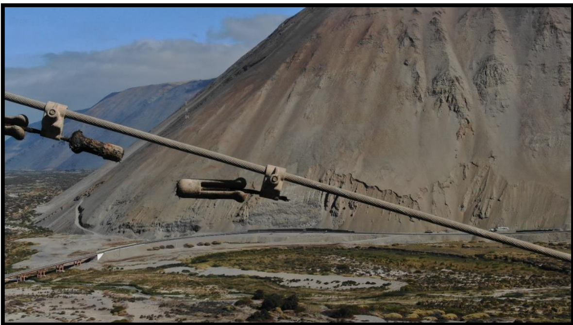
Imagen 67: Amortiguadores con corrosión.
