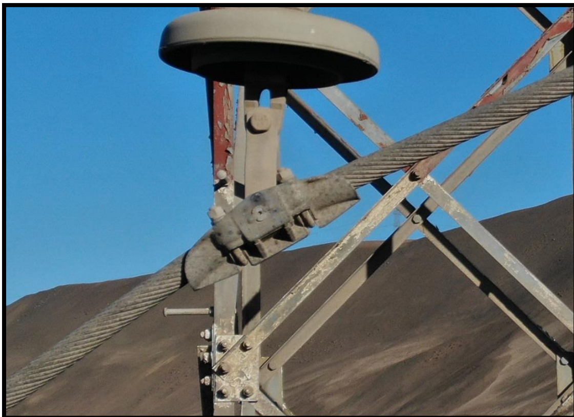
Imagen 131: Ferretería, grampa de suspensión.
