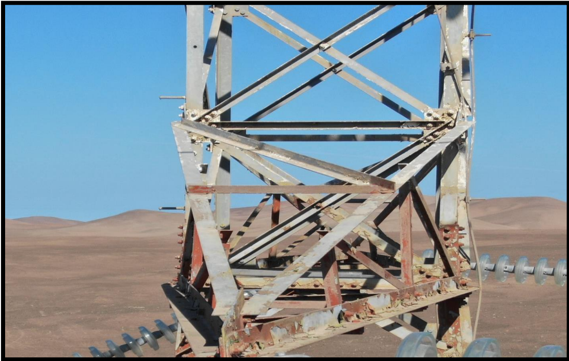
Imagen 142: Estructura, pintura mal estado.
