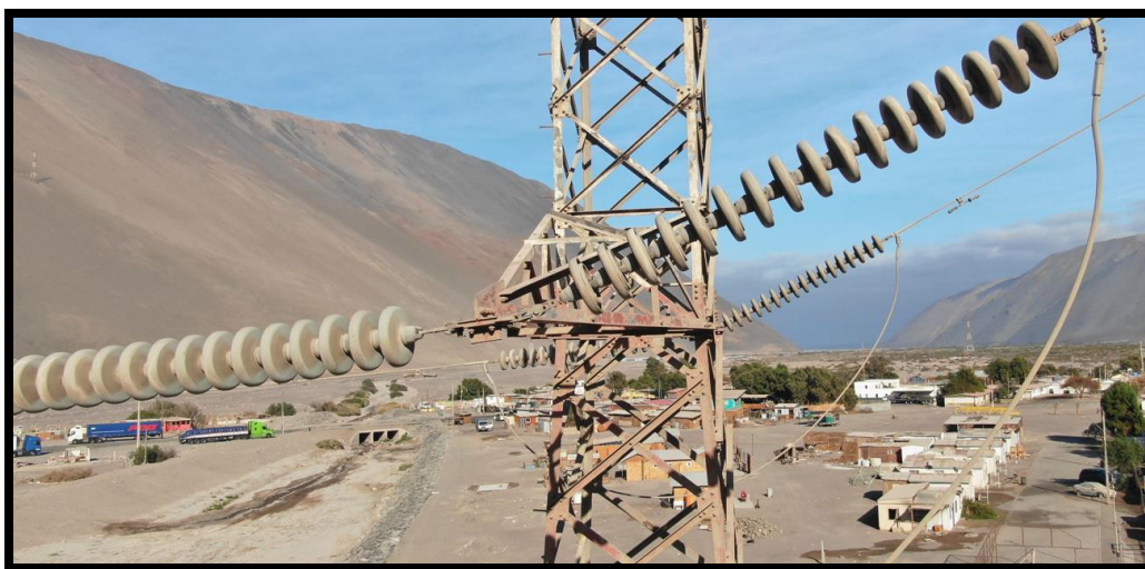
Imagen 1: Estado de aislación siliconado.
