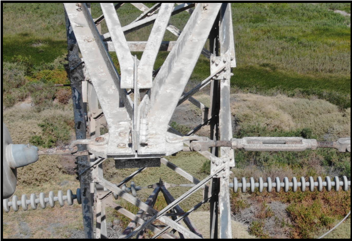
Imagen 102: Ferreteria con corrosion.
