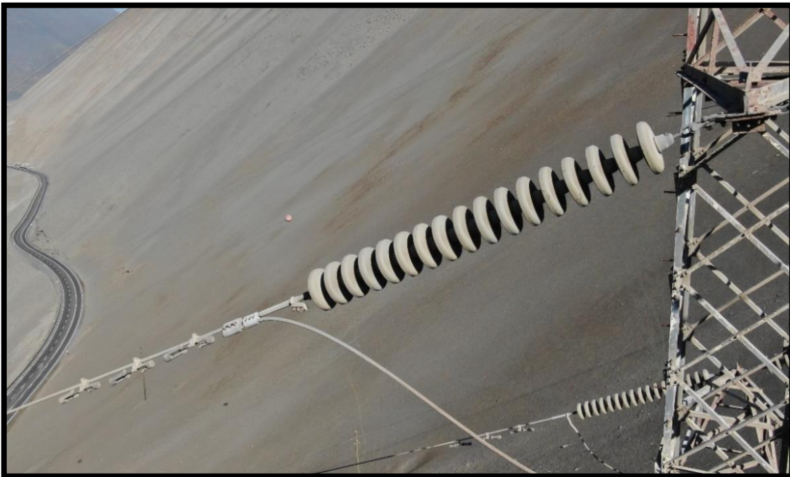
Imagen 114: Prensas en puente fase superior, entrada y salida.
