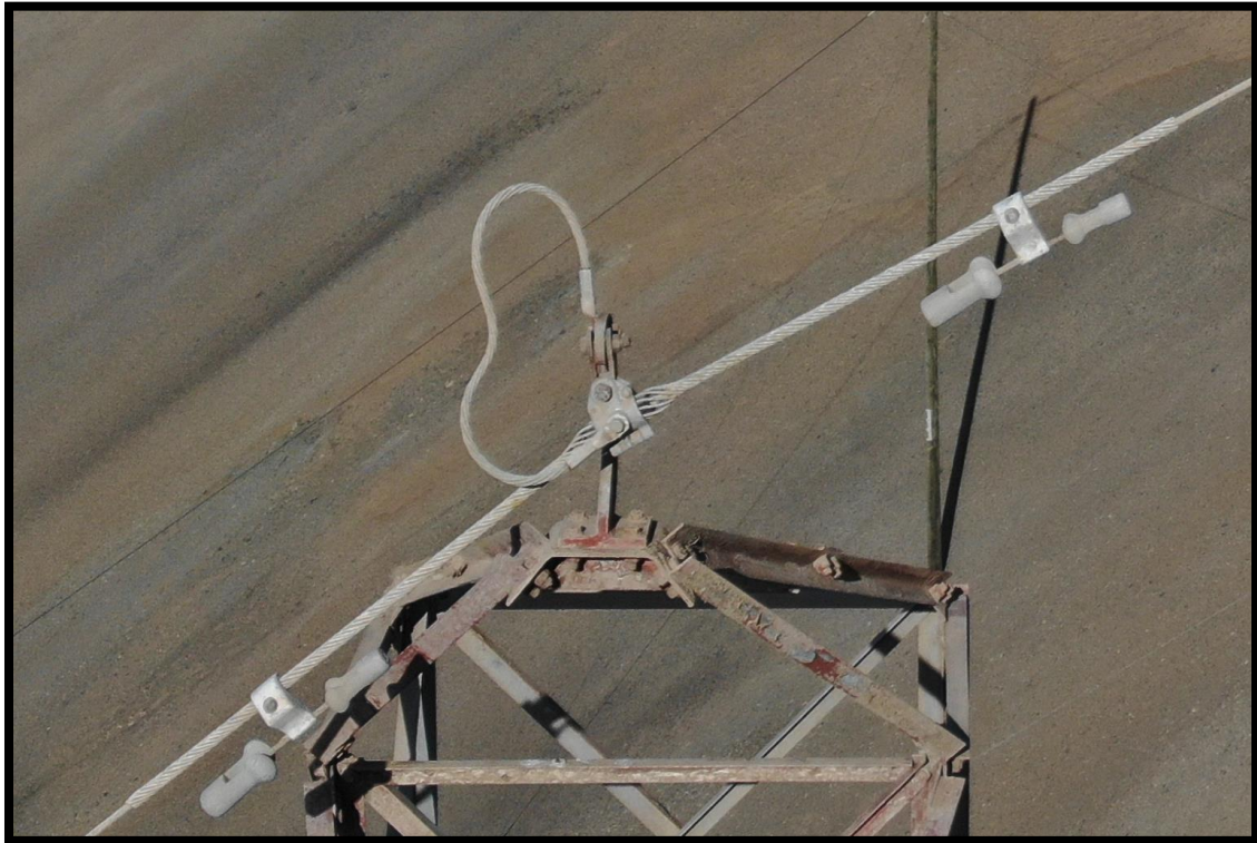
Imagen 124: Ferreteria cable de guardia.
