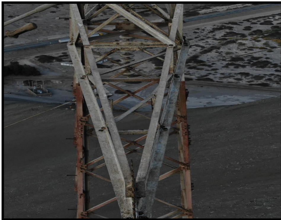
Imagen 29: Estructura, pintura mal estado.
