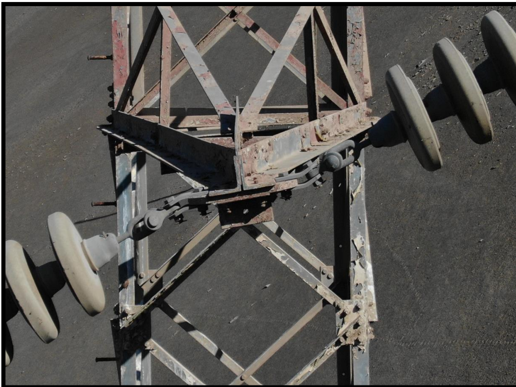
Imagen 113: Ferretería, punta de cruceta superior doblada.
