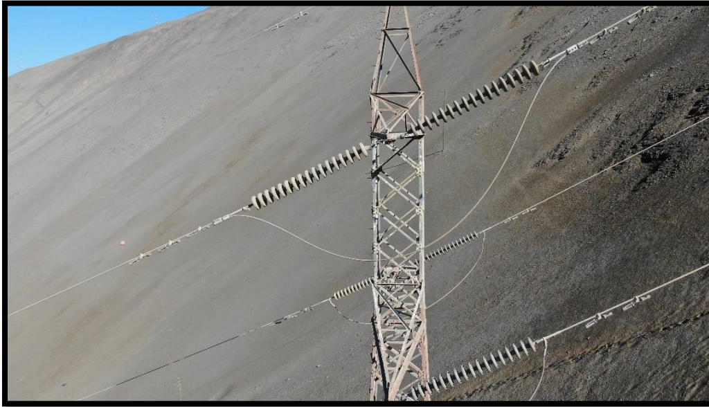
Imagen 112: Aislación siliconada.
