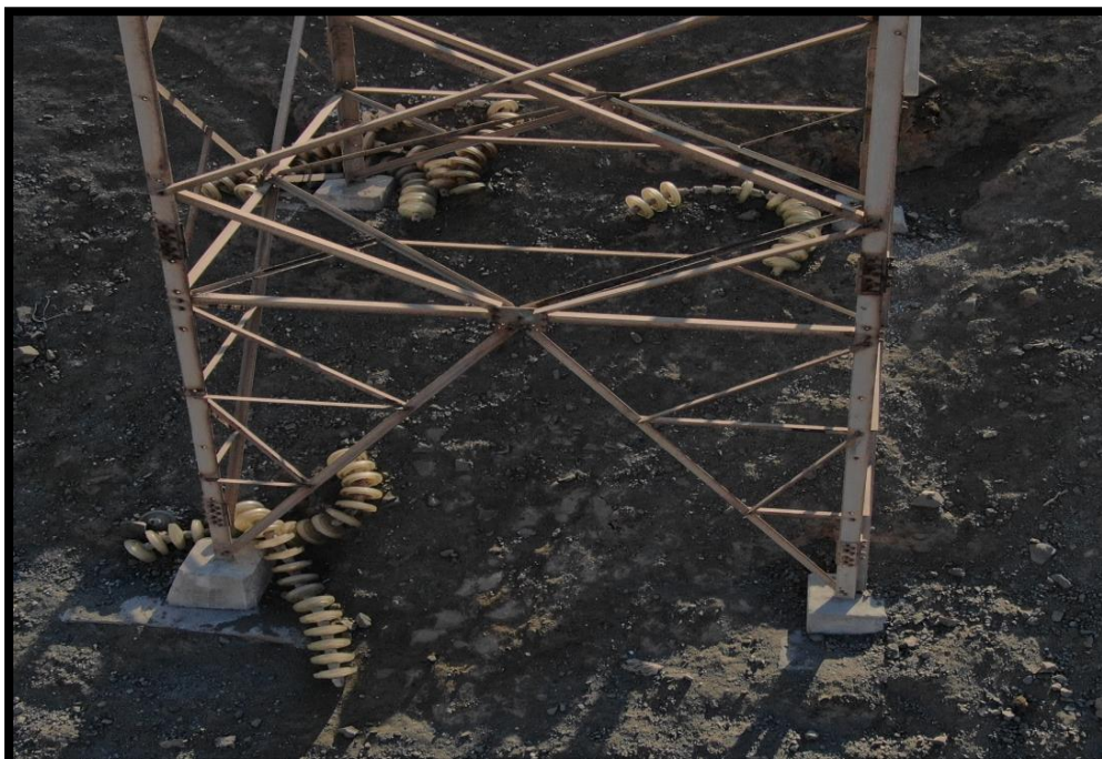
Imagen 69: Acopio materiales en fundaciones.
