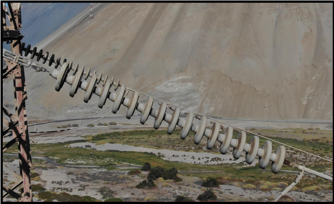
Imagen 66: Aislación siliconada.
