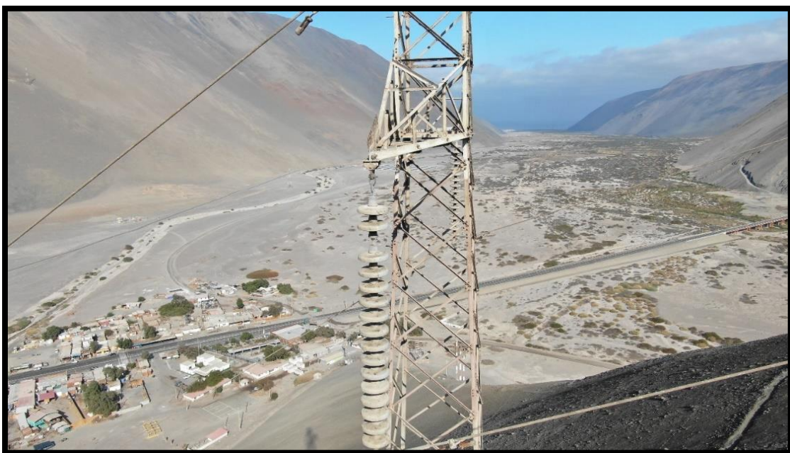
Imagen 25: 1 Aislador quebrado fase inferior derecha.
