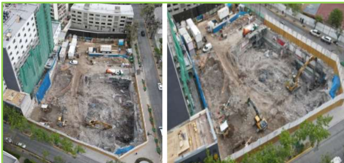
Imagen 5: Vista de altura de cierre acústico colindante calle Almirante Pastene, calle Pérez Valenzuela, y cierre acústico colindante a calle Manuel Montt.
