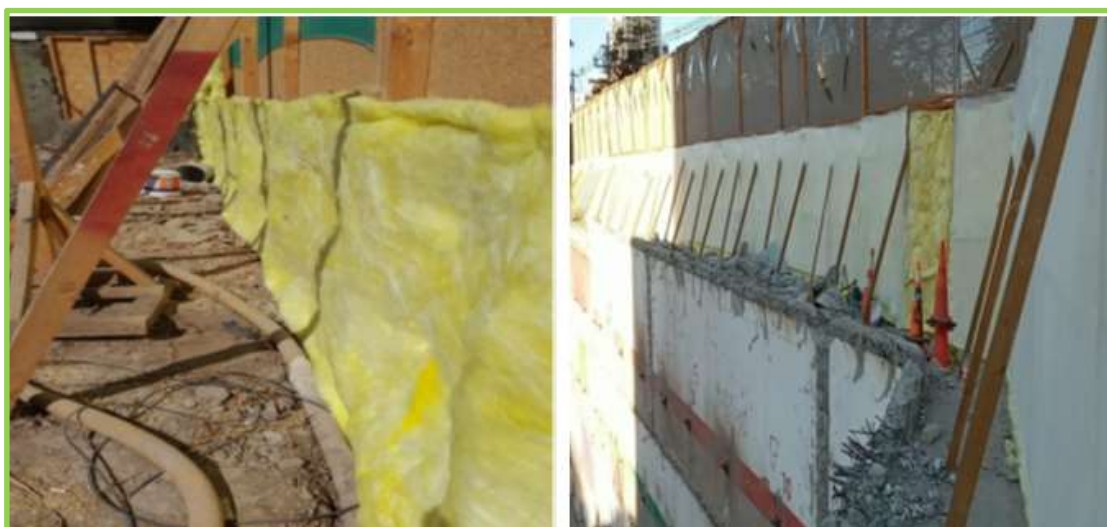
Imagen 4: Levantamiento cierre acústico colindante calle Almirante Pastene, vista obra (Izq.), y cierre por calle Pérez Valenzuela, vista obra (Der.).
