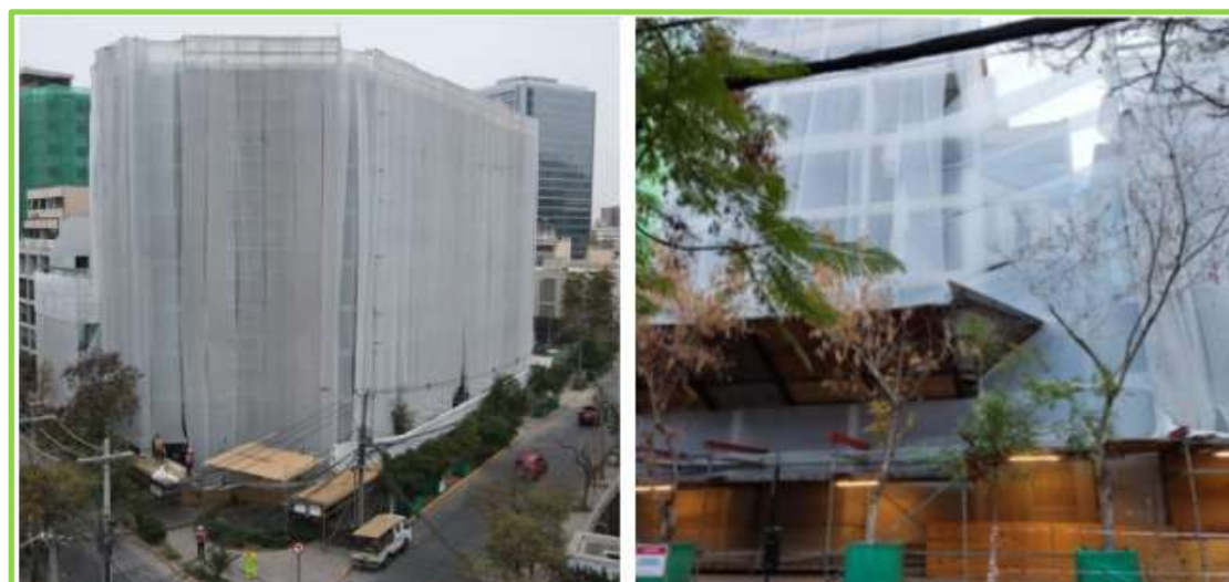
Imagen 2: Protección de fachada con malla raschel e instalación de andamios, Almirante Pastene.
