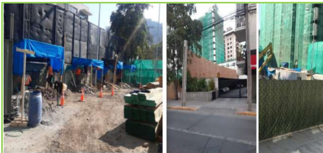
Imagen 3: Levantamiento cierre acústico colindante a Manuel Montt y estaciones de trabajo, vista obra (Izq.) y vista hacia edificio vecino, antes y después de revestimiento con gráfica amigable de vegetación (Der.).
