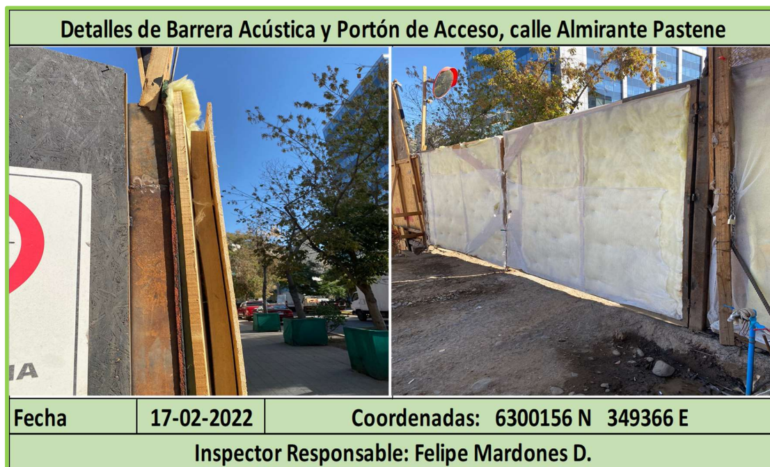
Imagen 9: Registro de Fotografías Fechadas y Georreferenciadas para detalles de MC3 y portón de acceso a obra.
