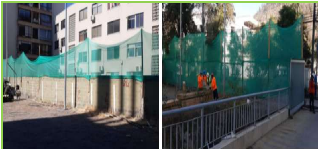
Imagen 1: Preparación de instalación de faena, cierre perimetral inicial.
