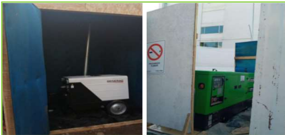
Imagen 6: Encierros acústicos tipo Cubículos para generadores eléctricos, diurno (Der.) y nocturno (Izq.).
