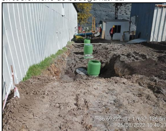
Figura 5. Instalación y conexión de estanques en sector norte de bodega RESPEL.
