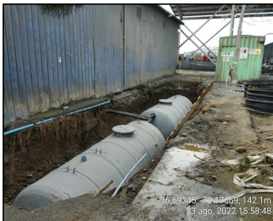
Figura 4. Instalación y conexión de estanques en sector sur de bodega RESPEL.
