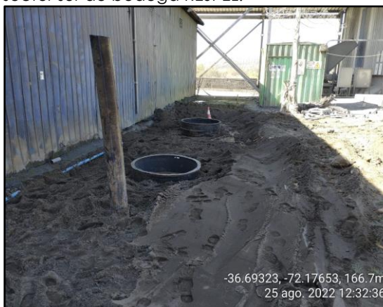
Figura 6. Instalación y conexión de estanques en sector sur de bodega RESPEL.
