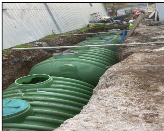
Figura 3. Instalación y conexión de estanques en sector norte de bodega RESPEL.
