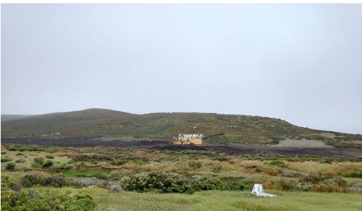
Fig. 11. Imagen del final del área de explotación donde se ubica la planta flotante. Hito de mensura como referencia.
