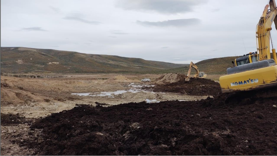
Fig. 1. Foto de fecha 16/12/2022 donde pueden observarse retroexcavadoras cerrando la piscina donde flotaba la planta de lavado de gravas.
