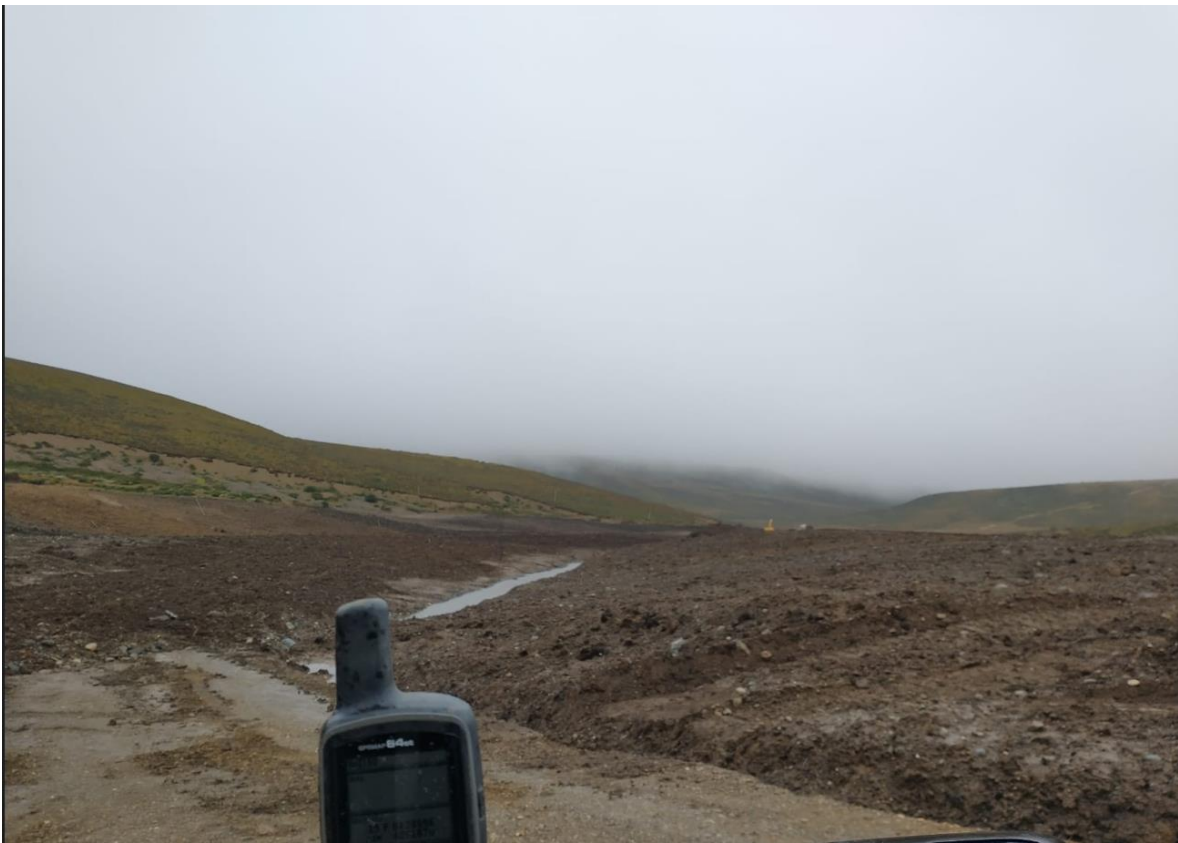
Fig. 6. Misma ubicación de Fig.1, pero orientada hacia el Sur. Muestra la franja de explotación ahora rellena y nivelada en relación a la superficie, y un cauce natural. A lo lejos, puede apreciarse la máquina retroexcavadora trabajando en la reconstitución y la planta móvil instalada al final de la franja.
